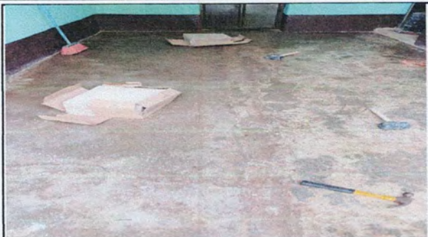
Foto 1: INSTALACION DE PISO CERÁMICO EN AULAS
