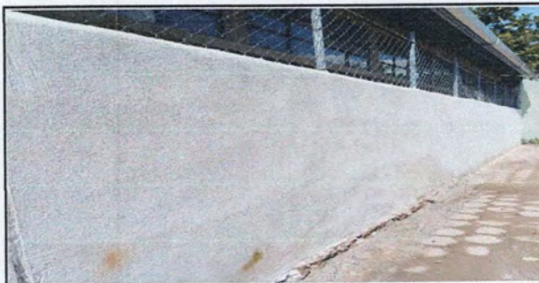
Foto 6: REPELLO MURO PERIMETRAL
