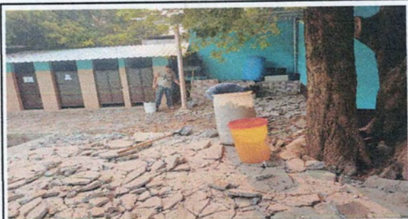
Foto 9: SUSTITUCION DE PLANCHAS DE CONCRETO DE PATIO
