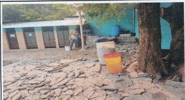
Foto 9: SUSTITUCION DE PLANCHAS DE CONCRETO DE PATIO
