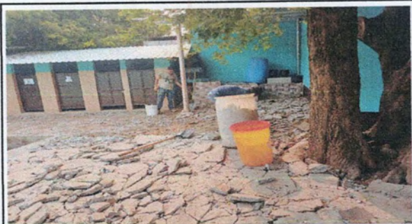
Foto 9: SUSTITUCION DE PLANCHAS DE CONCRETO DE PATIO
