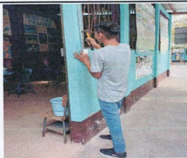
Foto 5: SUSTITUCIÓN DE INTERRUPTORES SIMPLES (CAJA, APAGADOR, ALAMBRADO Y DUCTO)
