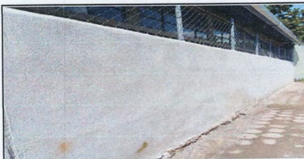
Foto 6: REPELLO MURO PERIMETRAL
