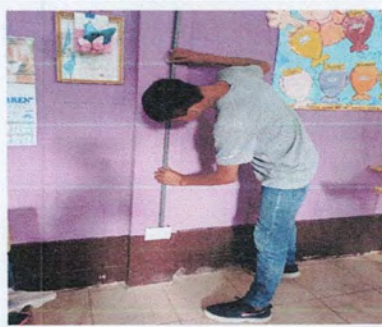
Foto 4: SUSTITUCION DE UNIDAD DE FUERZA (CAJA, TOMACORRIENTE, ALAMBRADO Y DUCTO)
