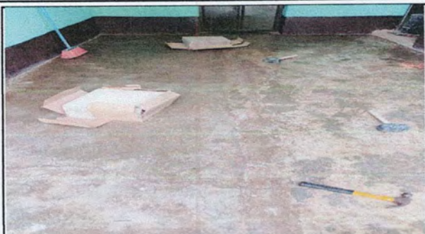
Foto 1: INSTALACION DE PISO CERÁMICO EN AULAS
