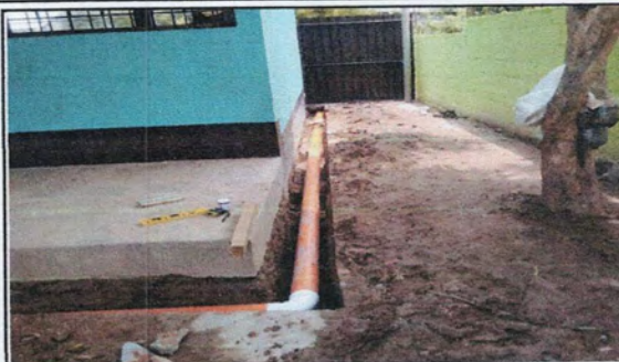
Foto 8: INSTALACIÓN DE TUBERIA PVC EN LÍNEA PRINCIPAL DE AGUA PLUVIAL
