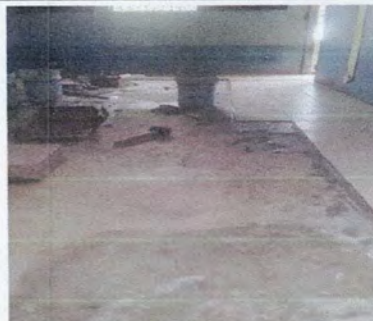
Foto 2: INSTALACION DE PISO CERÁMICO EN AULAS
