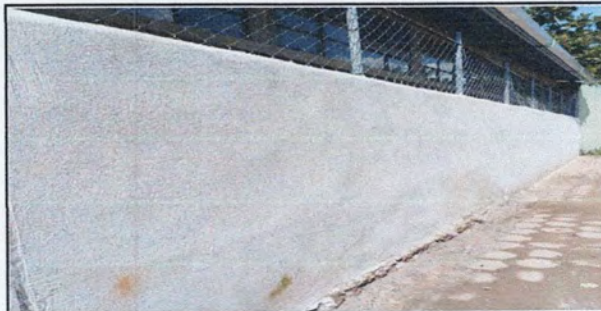
Foto 6: REPELLO MURO PERIMETRAL
