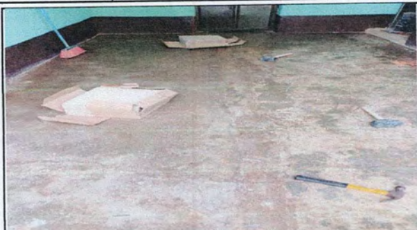
Foto 1: INSTALACION DE PISO CERÁMICO EN AULAS
