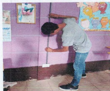
Foto 4: SUSTITUCION DE UNIDAD DE FUERZA (CAJA, TOMACORRIENTE, ALAMBRADO Y DUCTO)
