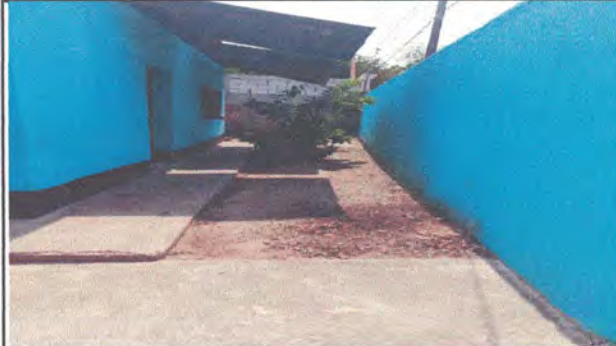
Foto 8: LOSA DE PATIO: Sustitución de planchas de concreto de patio
