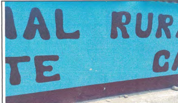
Foto 6: MURO PERIMETRAL: CERNIDO
