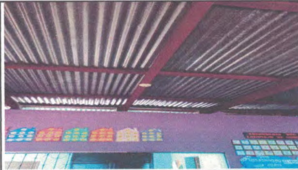
Foto 2: AULA: Sustitución de luminaria
