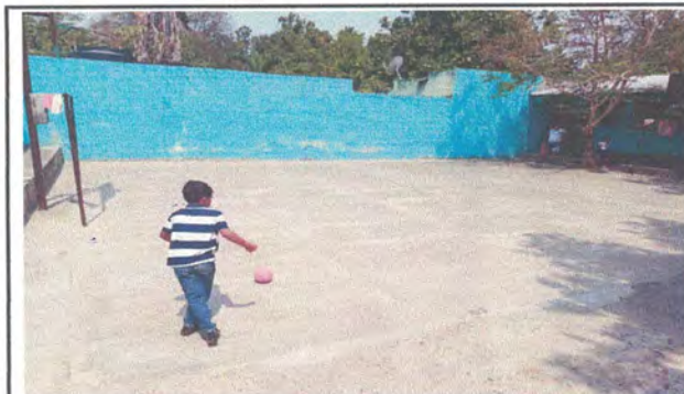
Foto 5: MURO PERIMETRAL: REPELLO
