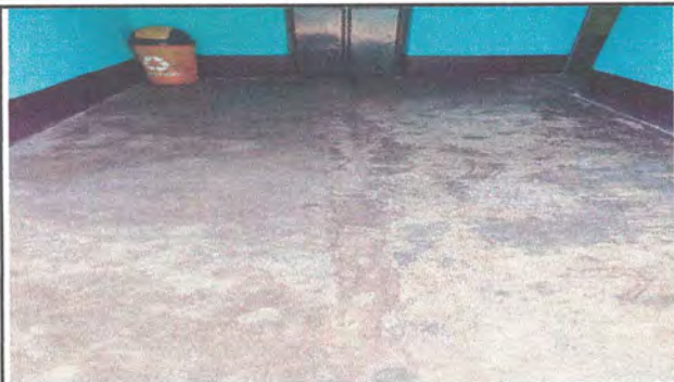
Foto 1: AULA: Instalación de piso cerámico
