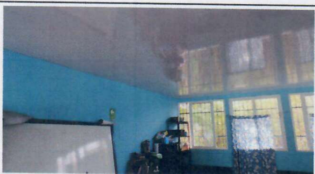
Instalación de cielo rason PVC, Duela Blanca
