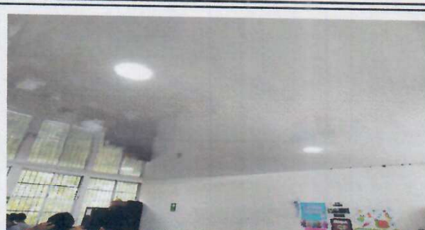
Foto 2: sustitución de lamparas LED.
