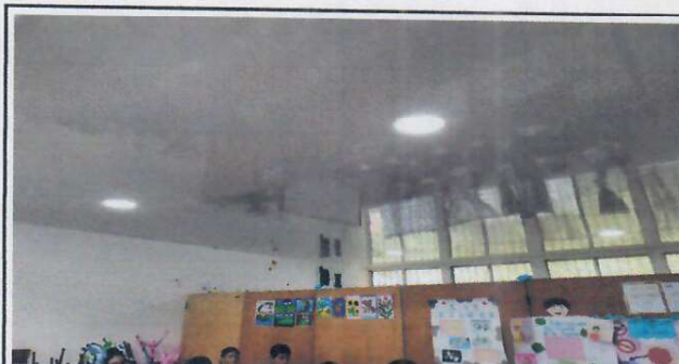
Foto 4: sustitución de bombillas por luces LED
