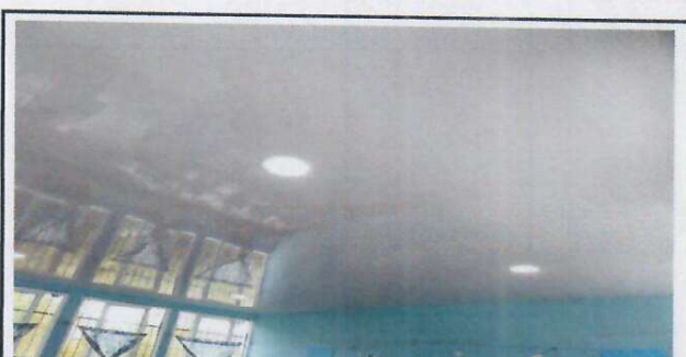
Foto 6: Instalación de cielo raso PVC dula Blanca y sustitución de lamparas LED.
