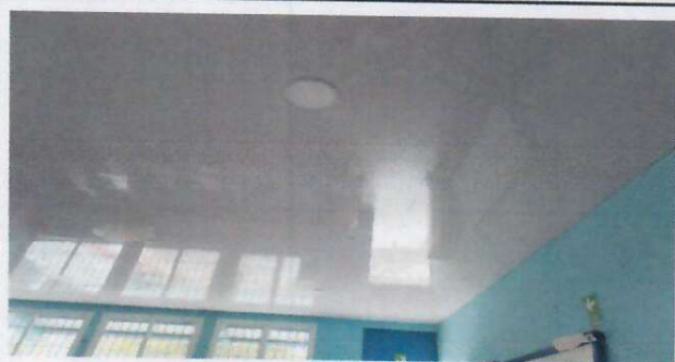
Foto1: Instalación de techo en aulas, montaje de bombillas, sustitución de bombillas o lamparas LED, para el cielo raso PVC. Duela Blanca.
