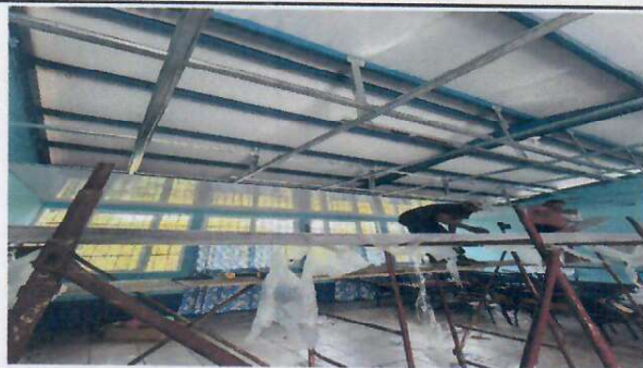
Foto 3: preparación de estructura portante para la instalación del cielo raso PVC Duela Blanca.
