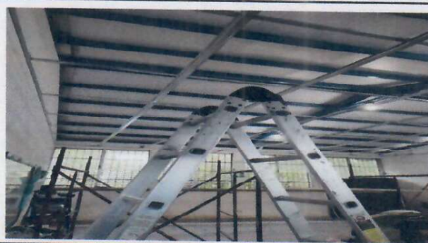
Foto 2: preparación de estructura portante para la instalación del cielo raso PVC Duela Blanca.
