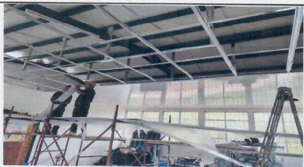
Foto 5: preparación de estructura portante para la instalación del cielo raso PVC Duela Blanca, Dando Inicio con la instalación de Duela Blanca.
