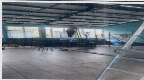
Foto 4: Desmontaje de bombillas, sustitución de lamparas LED.
