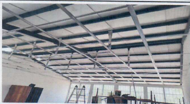
Foto 1: preparación de estructura portante para la instalación del cielo raso PVC Duela Blanca, desmontaje de bombillas, sustitución de lamparas LED.
