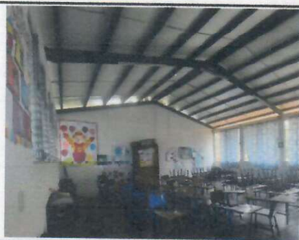
Foto 5: Reparación de Techo en Aulas, se instalará Cielo Raso PVC Duela Blanca
