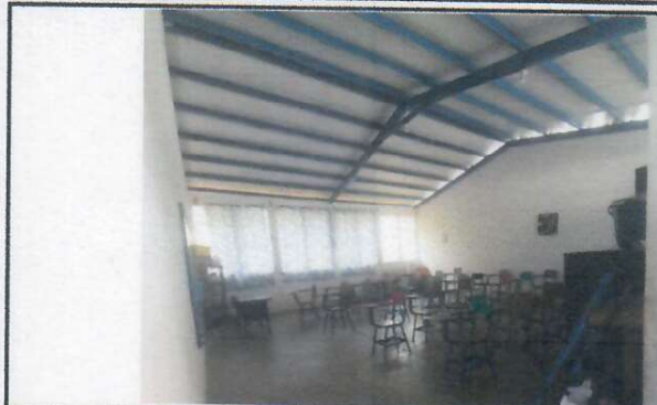
Foto 1: Reparación de Techo en Aulas, Desmontaje de Bombillas y Sustitución de Bombillas o Lámparas LED para Cielo Raso PVC. Duela Blanca.
