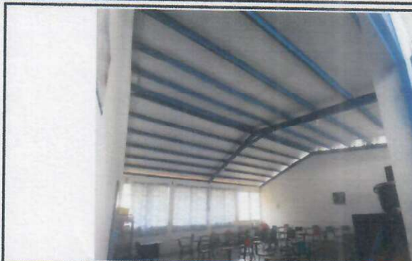
Foto 2: Reparación de Techo en Aulas, se instalará Cielo Raso PVC Duela Blanca
