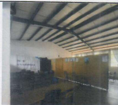
Foto 4: Reparación de Techo en Aulas, se instalará Cielo Raso PVC Duela Blanca
