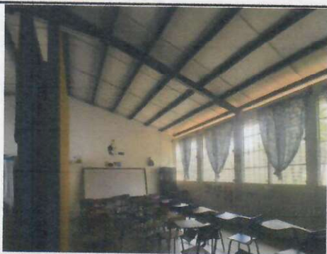
Foto 3: Reparación de Techo en Aulas, se instalará Cielo Raso PVC Duela Blanca
