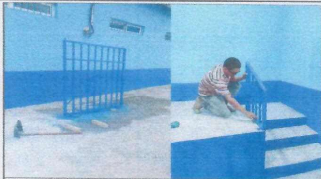
FOTO 7: INSTALACIÓN DE BARANDA METALICA EN ESCENARIO Y BALCON
