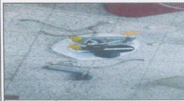
FOTO 5: SUSTITUCIÓN DE ACCESORIOS SANITARIOS
