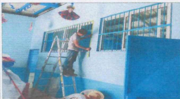
FOTO 3: PINTURA EN MUROS INTERIORES Y EXTERIORES
