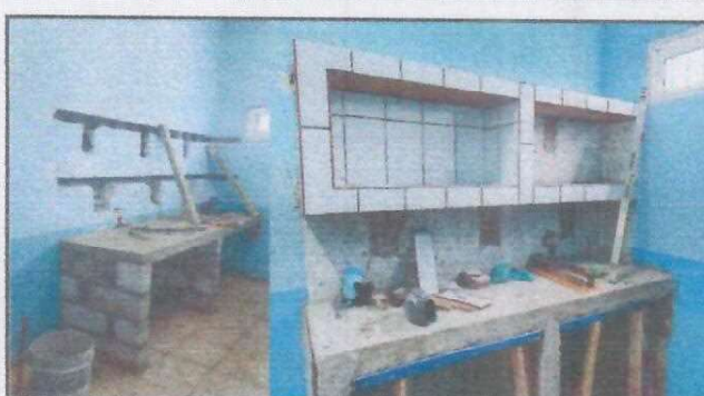
FOTO 10: ESTANTERIA DE CONCRETO AÉREA
