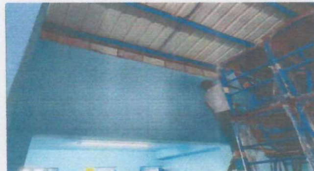
FOTO 4: CERRAMIENTO DE MOJINETES
