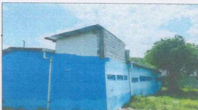
FOTO 9: REPELLO Y CERNIDO EN MURO EXTERIOR
