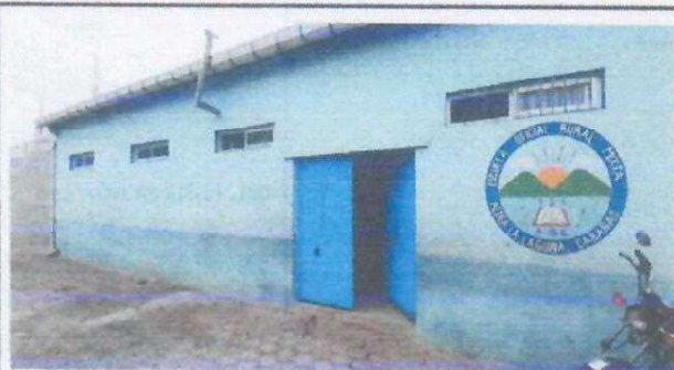
FOTO 3. PINTURA EN MUROS EXTERIORES E INTERIORES
