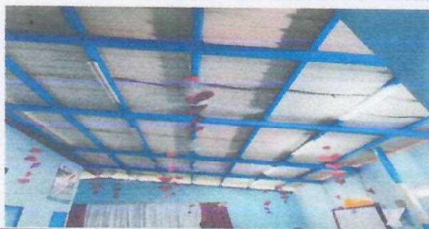
FOTO 5: INSTALACIÓN DE LÁMPARAS TIPO LED
