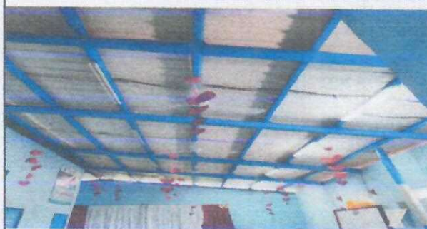
FOTO 4. SUSTITUCIÓN DE PLAFONERAS
