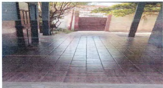
Foto 1: Reparación de piso cerámico de corredor 4
