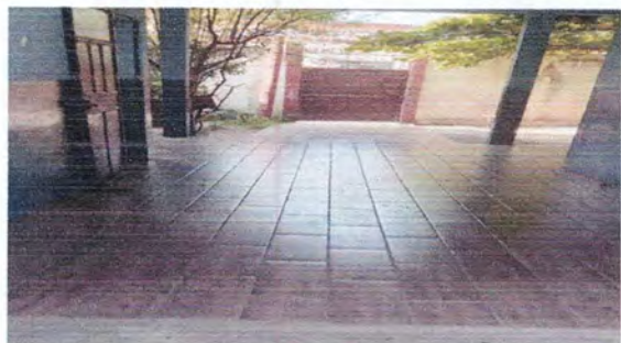
Foto1: Reparación de piso ceramico de corredor 4
