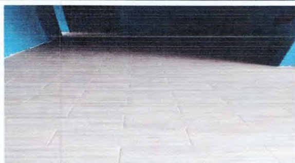
Foto 2: Reparación de piso cerámico de corredor 1
