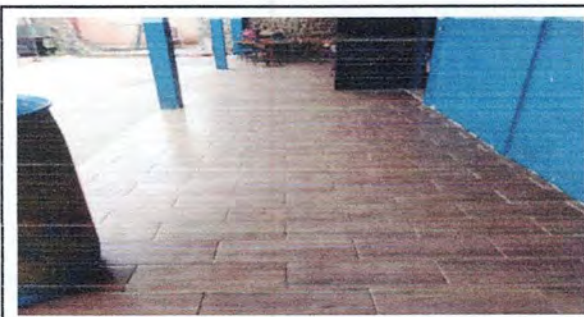
Foto 5: Reparación de piso cerámico de corredor 3
