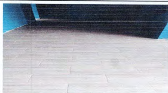
Foto 2: Reparación de piso cerámico de corredor 1
