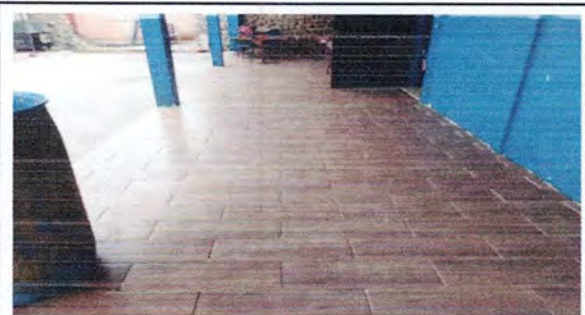
Foto 5: Reparación de piso cerámico de corredor 3
