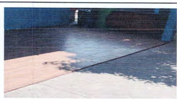
Foto 4: Reparación de piso cerámico de corredor 2
