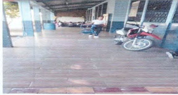
Foto 2: Reparación de piso cerámico de corredor 4
