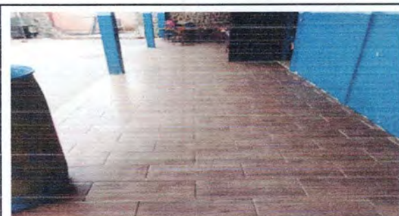
Foto 5: Reparación de piso cerámico de corredor 3
