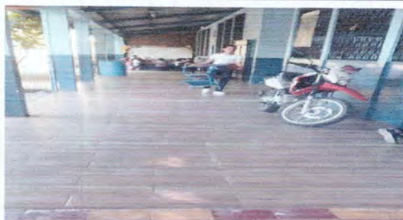
Foto 2: Reparación de piso ceramico de corredor 4
