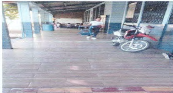
Foto 2: Reparación de piso cerámico de corredor 4
