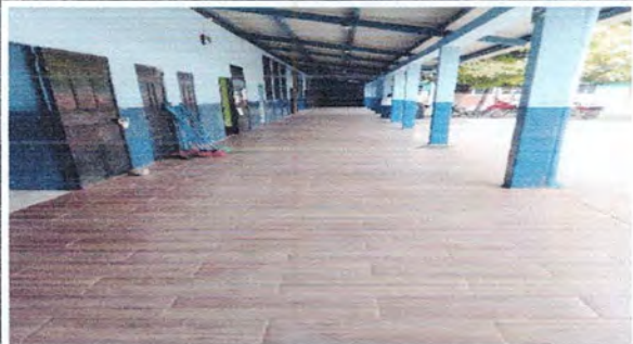
Foto 1: Reparación de piso cerámico de corredor 1
