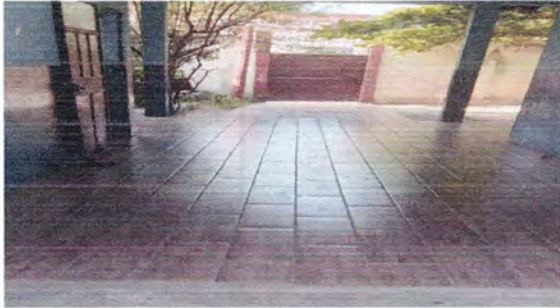
Foto1: Reparación de piso cerámico de corredor 4
