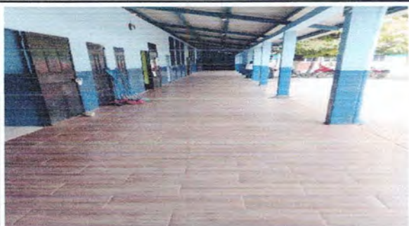
Foto 1: Reparación de piso cerámico de corredor 1
