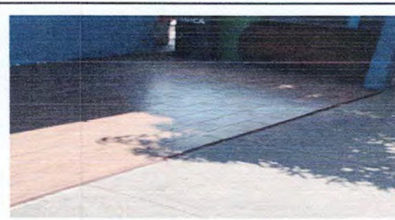
Foto 4: Reparación de piso cerámico de corredor 2
