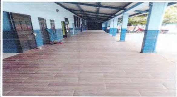
Foto 1: Reparación de piso cerámico de corredor 1
