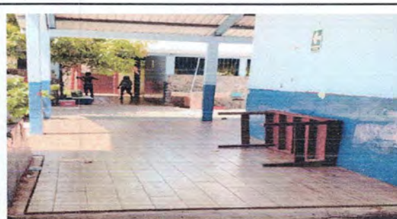
Foto 6: Reparación de piso cerámico de corredor 3
