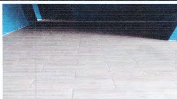
Foto 2: Reparación de piso cerámico de corredor 1
