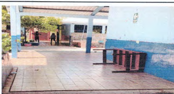
Foto 6: Reparación de piso cerámico de corredor 3
