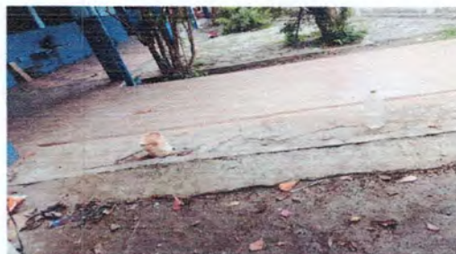
Foto 2: Reparación de piso ceramico de corredor 4
