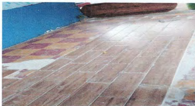
Foto 3: Reparación de piso ceramico de corredor 2
