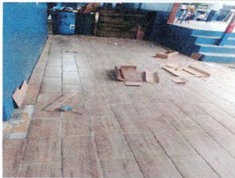
Foto 5: Reparación de piso cerámico de corredor 3
