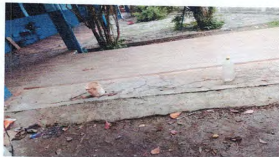
Foto 2: Reparación de piso cerámico de corredor 4
