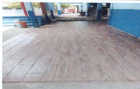
Foto 4: Reparación de piso ceramico de corredor 2
