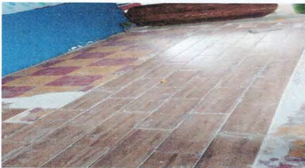
Foto 3: Reparación de piso cerámico de corredor 2
