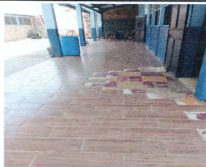
Foto 6: Reparación de piso cerámico de corredor 3
