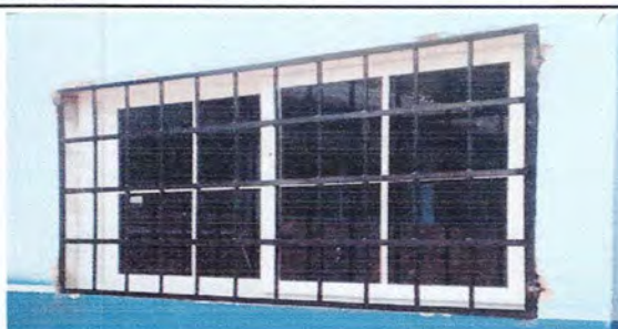
Foto 4: Sustición de balcón de cocina
