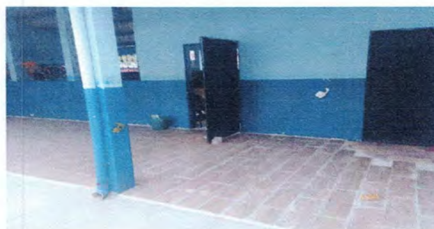
Foto 2: Reparación de piso ceramico de corredor 1
