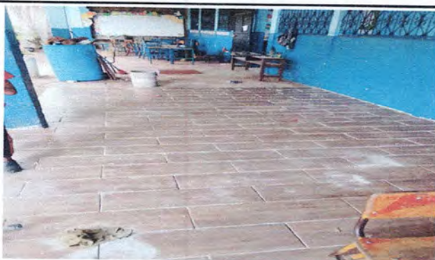
Foto 3: Reparación de piso cerámico de corredor 4
