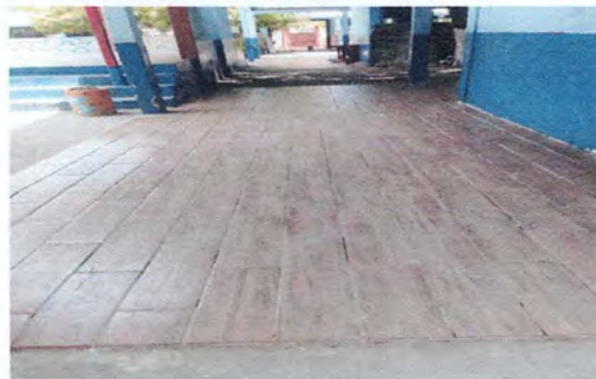
Foto 4: Reparación de piso ceramico de corredor 2
