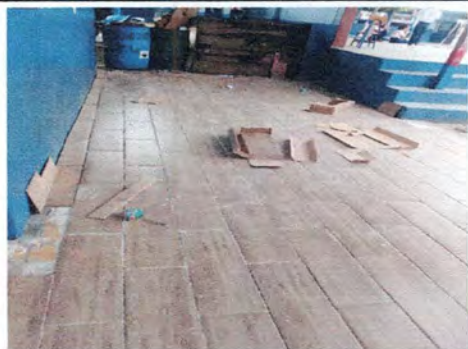
Foto 5: Reparación de piso ceramico de corredor 3
