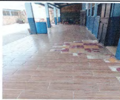
Foto 6: Reparación de piso ceramico de corredor 3
