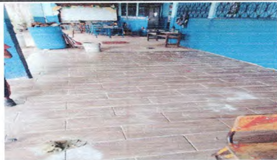
Foto 3: Reparación de piso cerámico de corredor 4
