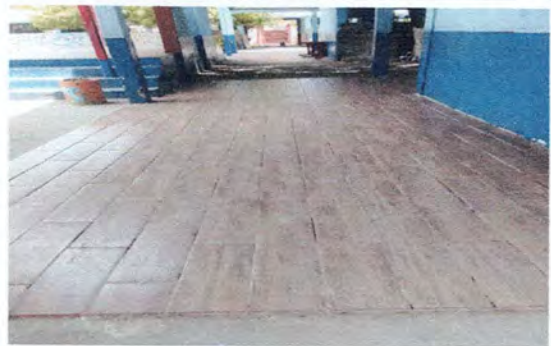
Foto 4: Reparación de piso cerámico de corredor 2
