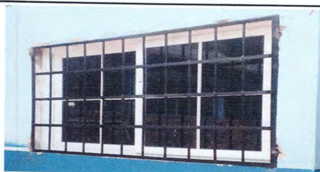
Foto 4: Sustitución de balcón de cocina
