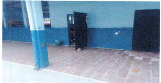
Foto 2: Reparación de piso cerámico de corredor 1
