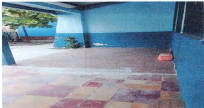
Foto 1: Reparación de piso ceramico de corredor 1
