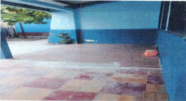
Foto 1: Reparación de piso cerámico de corredor 1
