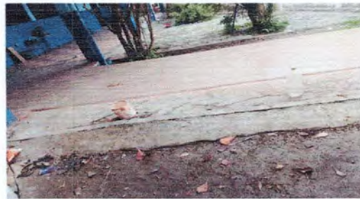
Foto 2: Reparación de piso cerámico de corredor 4
