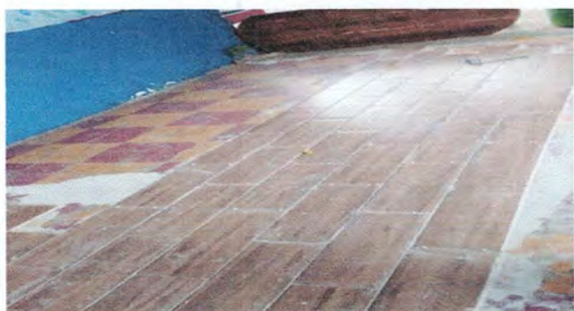
Foto 3: Reparación de piso ceramico de corredor 2
