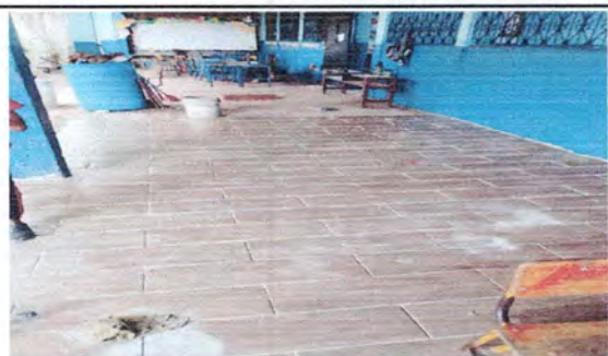
Foto 3: Reparación de piso ceramico de corredor 4
