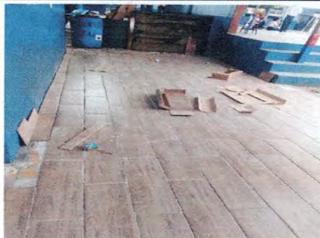
Foto 5: Reparación de piso ceramico de corredor 3
