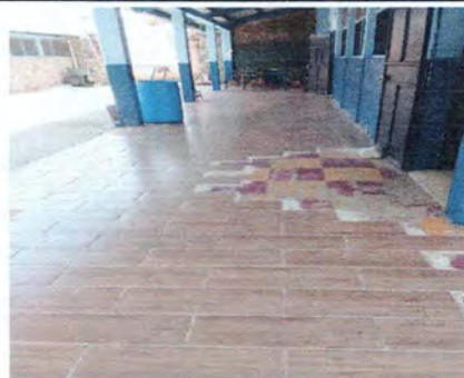
Foto 6: Reparación de piso ceramico de corredor 3
