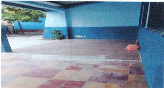
Foto 1: Reparación de piso ceramico de corredor 1
