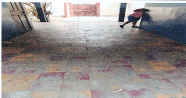
Foto 5: Reparación de piso ceramico de corredor 4
