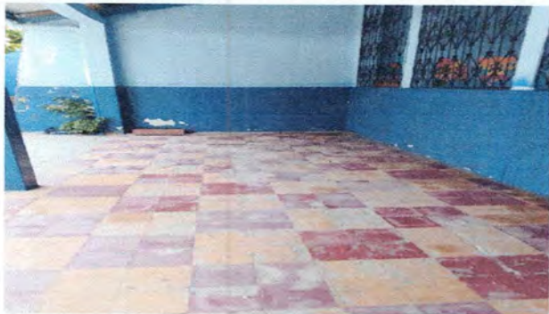
Foto1: Reparación de piso ceramico de corredor 1
