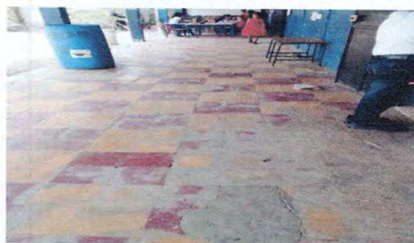
Foto 4: Reparación de piso ceramico de corredor 3
