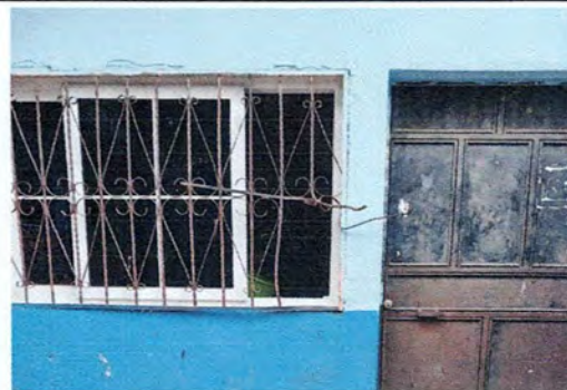
Foto 6: Sustitución de balcón de cocina
