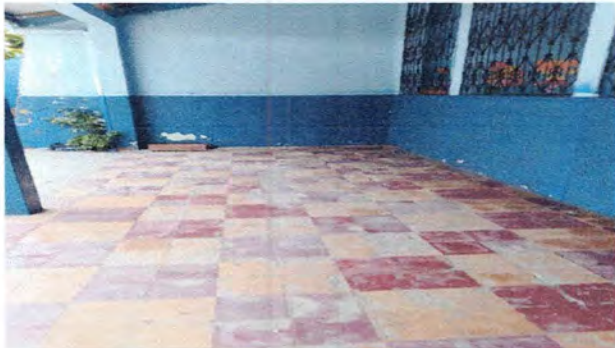
Foto1: Reparación de piso ceramico de corredor 1
