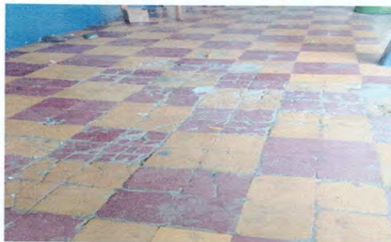
Foto 2: Reparación de piso ceramico de corredor 1
