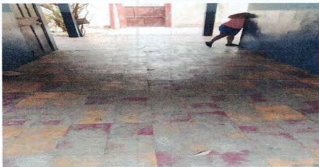
Foto 5: Reparación de piso ceramico de corredor 4
