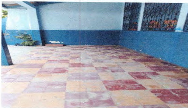
Foto1: Reparación de piso ceramico de corredor 1
