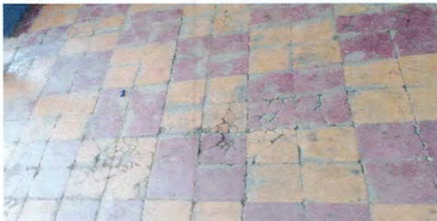
Foto 3: Reparación de piso ceramico de corredor 2
