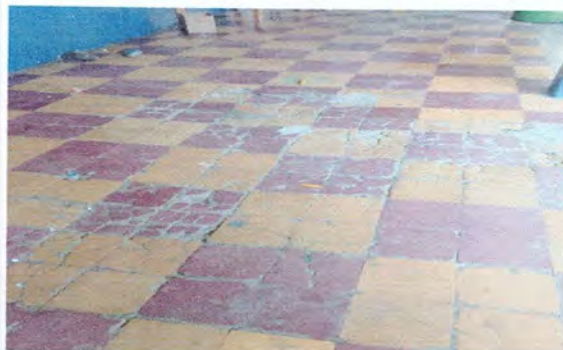
Foto 2: Reparación de piso ceramico de corredor 1
