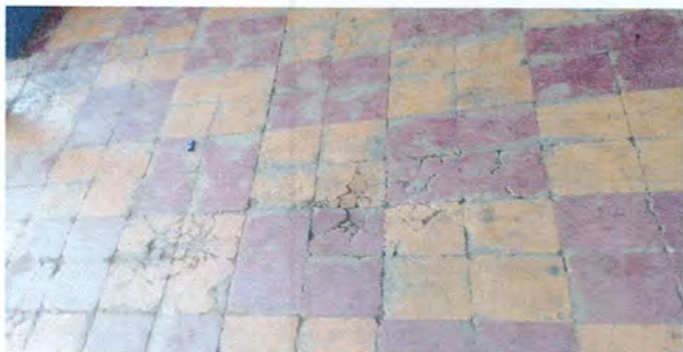
Foto 3: Reparación de piso ceramico de corredor 2
