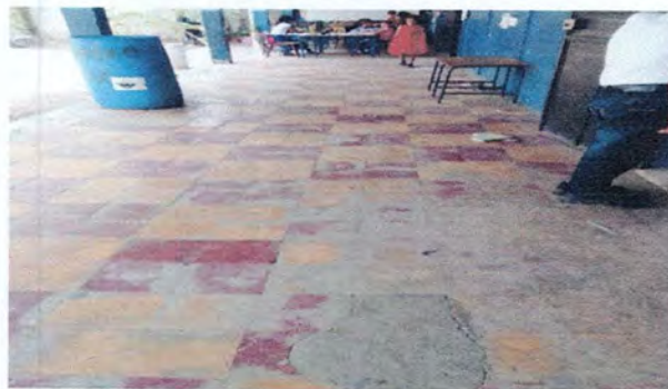
Foto 4: Reparación de piso ceramico de corredor 3
