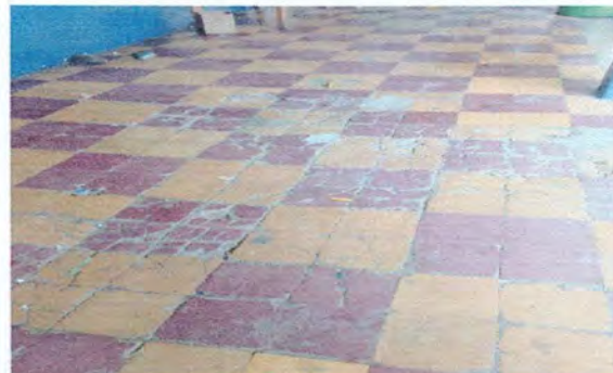
Foto 2: Reparación de piso ceramico de corredor 1
