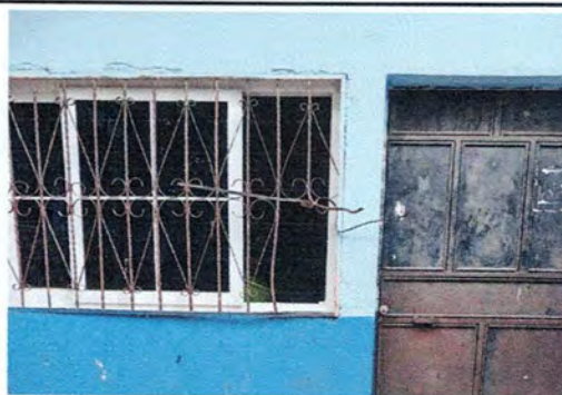
Foto 6: Sustitución de balcón de cocina
