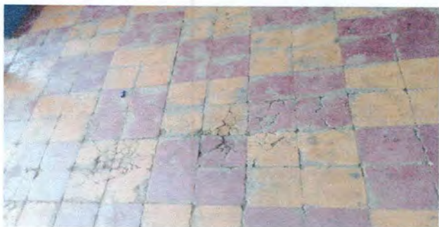
Foto 3: Reparación de piso ceramico de corredor 2
