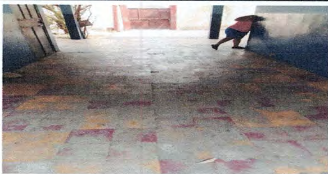
Foto 5: Reparación de piso ceramico de corredor 4
