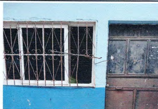
Foto 6: Sustitución de balcón de cocina
