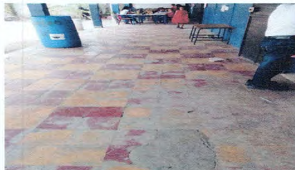
Foto 4: Reparación de piso ceramico de corredor 3
