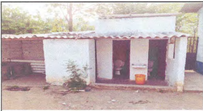
Foto 3: BAÑOS QUE SERAN INTERVENIDOS EN EL REMOZAMIENTO, EN LA COLOCACION DE AZULEJO, REPELLO Y CERNIDO, CAMBIO DE DEPOSITO DE AGUA Y DEMAS RENGONES INCLUIDOS EN EL PRESUPUESTO
