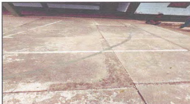
Foto 13: PISO DE CEMENTO EN CANCHA QUE NECESITA REPOSICION, (DEMOLICION DE 15 CM DE PLANCHAS EXISTENTES, PREPERACION DEL AREA DONDE SE VA A FUNDIR NUEVAMENTE LA PLANCHA DE CONCRETO)
