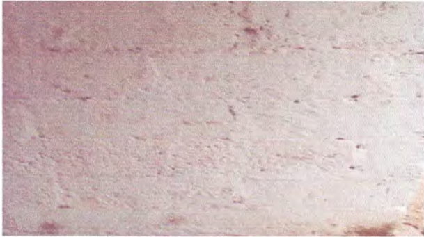
FOTO 14: PARED DONDE SE INSTALARAN TOMACORRIENTES E INTERRUPTORES
