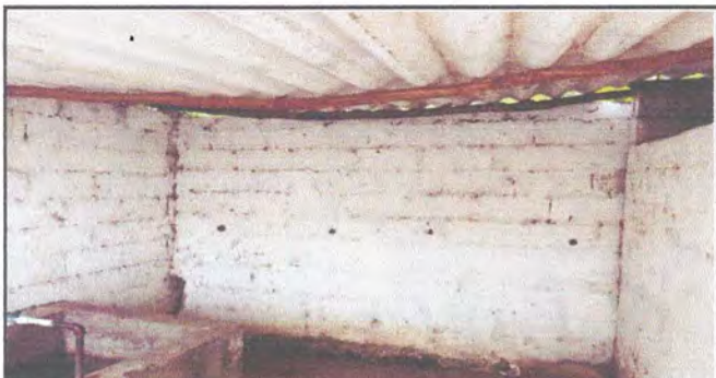
FOTO 5: MURO QUE NECESITA SER SUSTITUIDO YA QUE SE ENCUENTRA CON DAÑOS Y ESTA PROPENSO A DERRUMBARSE.. ESTE MURO COMO SE VE MUESTRA YA UN VENCIMIENTO LO QUE PROVOCA UN DESNIVEL VERTICAL.
