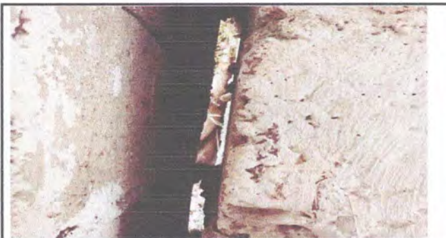
FOTO 6: MURO QUE NECESITA SER SUSTITUIDO YA QUE SE ENCUENTRA CON DAÑOS Y ESTA PROPENSO A DERRUMBARSE..
