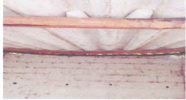
FOTO 15: EN LA NUEVA ESTRUCTURA SE INSTALARAN CABLEADO, PLAFONERAS Y BOMBILLAS
