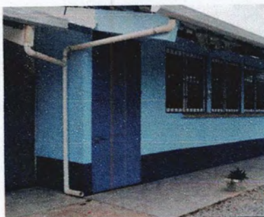
Foto 3: Pintura en Muros Exteriores
