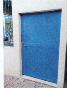
Foto 6: Instalación de puerta en Cocina
