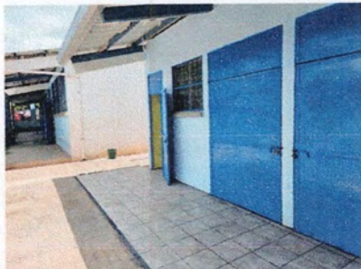
Foto 5: Mantenimiento a Puertas de Aulas y Dirección
