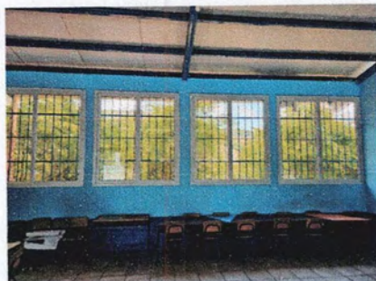
Foto1: Instalación de Ventanas PVC
