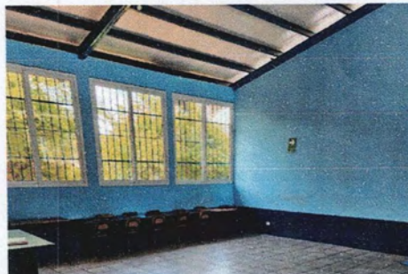
Foto 2: Pintura en muros interiores
