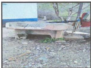
4.2 Sustitución de pila de concreto de dos lavaderos
