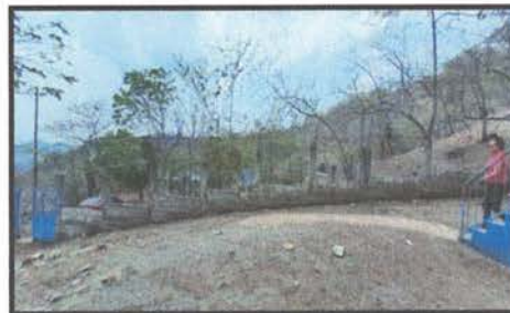
4.5 Reparación de losa de concreto en patio
