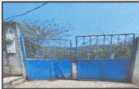
4.1 Mantenimiento a portón de metal de ingreso a la escuela
