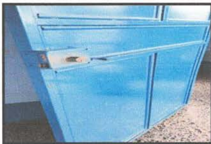
3.3 Sustitución de chapa en puerta de cocina
