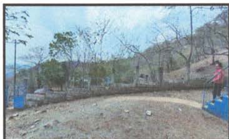
4.4 Aplicación de repello de muro perimetral
