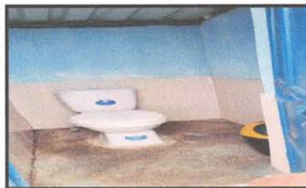
2.3 Sustitución de piso líquido por piso de granito en baños
