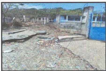
4.6 Reparación de muro perimetral
