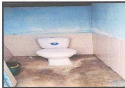
2.1 Sustitución de inodoros
