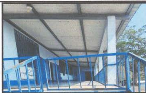
4.7 Pintura en muros exteriores e interiores
