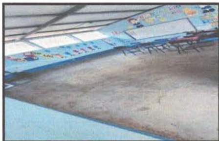
FOTO 1.1. Sustitución de piso líquido por piso de granito en aula 1 y 2
