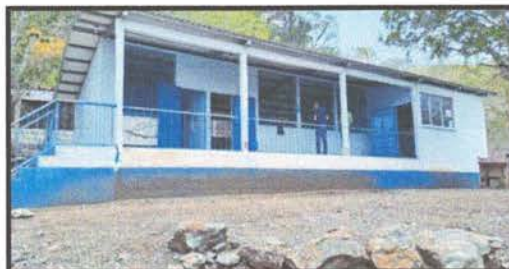
4.3 Sustitución de canal de pvc
