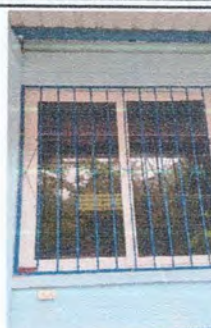
Foto 2: Ventana de PVC de la Cocina.
