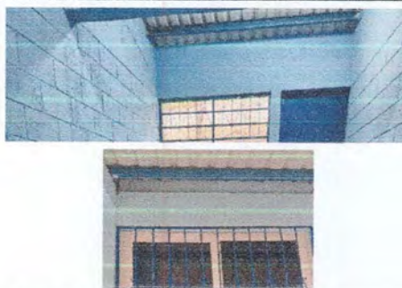
Foto 3: Muro entavica de la cocina.
