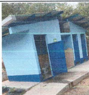
Foto 3: Mantenimiento de Puertas deterioradas.
