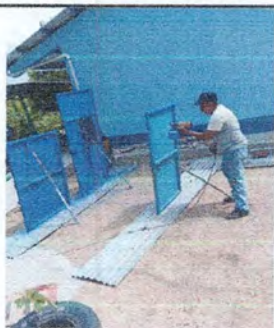
Foto 3: Proceso del mantenimiento de Puertas deterioradas.
