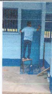
Foto 2: Proceso del mantenimiento de Puerta de aula.
