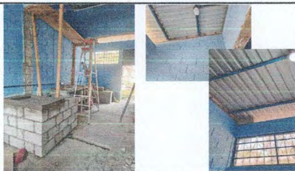
Foto 3: Proceso de entavicación de muro en la cocina.
