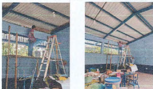
Foto 5: Entavacación de muro en aula.
