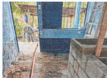
Foto 2: Sustitución de ventana de la Cocina.
