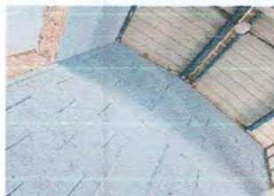
Foto 1: Luminarias del aula.
