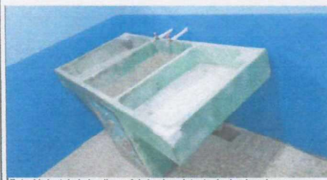
Foto 11: Instalada la pila prefabricada existente de dos lavaderos con drenaje y agua.
