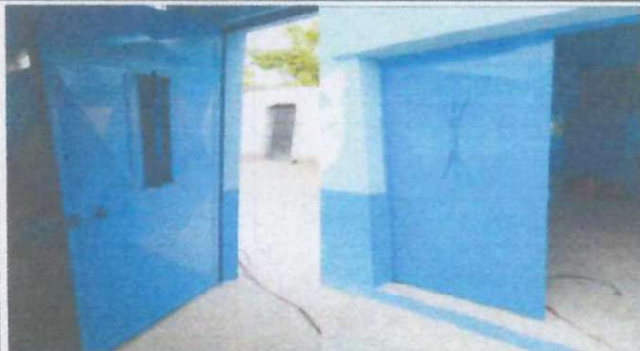
Foto 7: Mantenimiento completo al portón
