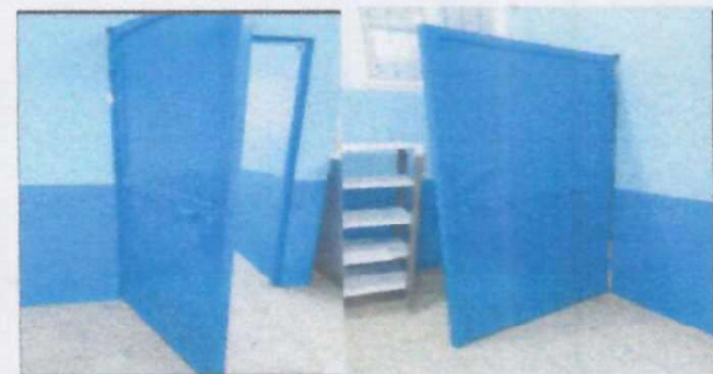
Foto 6: mantenimiento completo a estructura (puertas de aulas)
