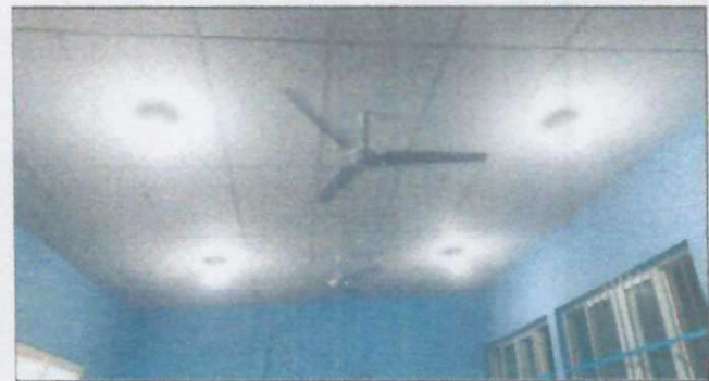
Foto 4: se sustituyó completamente la iluminación. (aula)
