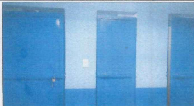
Foto 8: mantenimiento completo a estructura a puertas del servicio de sanitario.
