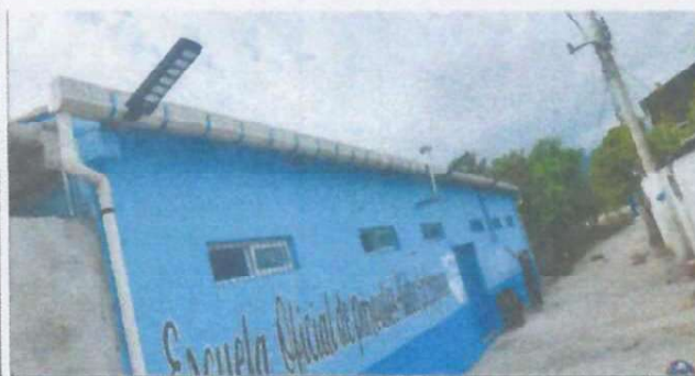
Foto 5: se instalaron las lamparas solares en exterior.
