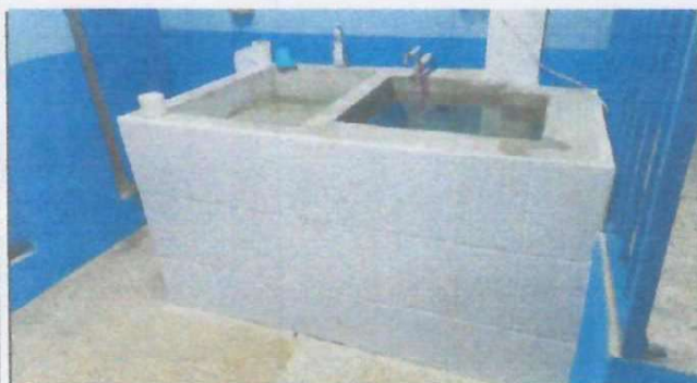
Foto 9: Instalada la pila de mampostería reforzada.
