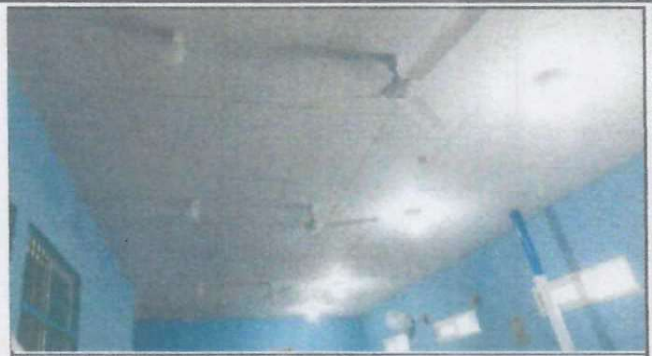
Foto 2: Se instaló el cielo falso. (corredor)
