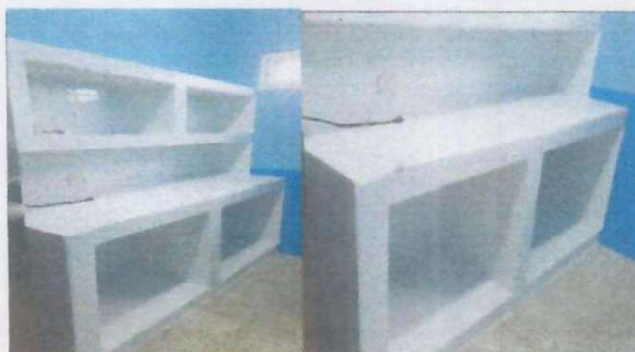
Foto 10: Instalada la mesa de trabajo de concreto y azulejo.
