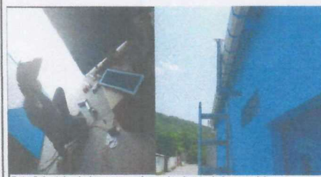
Foto 5: Instalando lamparas solares. ( enfrente de la escuela)
