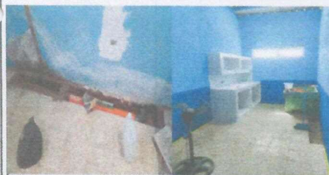
Foto 11: Instalando pila prefabricada existente de dos lavaderos incluye drenaje y agua.
