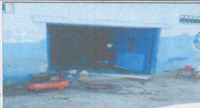
Foto 7: Mantenimiento a porton de metal
