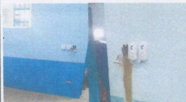
Foto 3: Sustituyendo interruptores dobles ( aulas)
