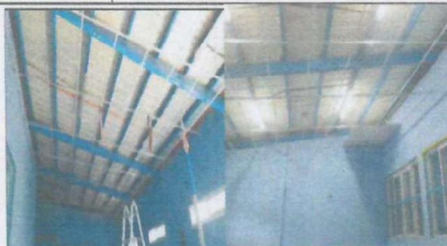
Foto 2: Instalando el cielo falso. ( corredor y aula)
