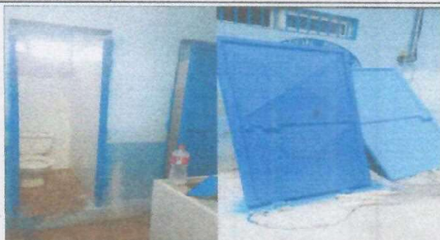
Foto 8: mantenimiento a estructura (puertas de sanitario)
