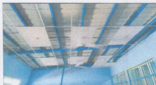
Foto 4: Sustituyendo la iluminación ( aula)
