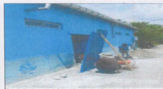
Foto 6: dando mantenimiento a la estructura ( puerta aula)
