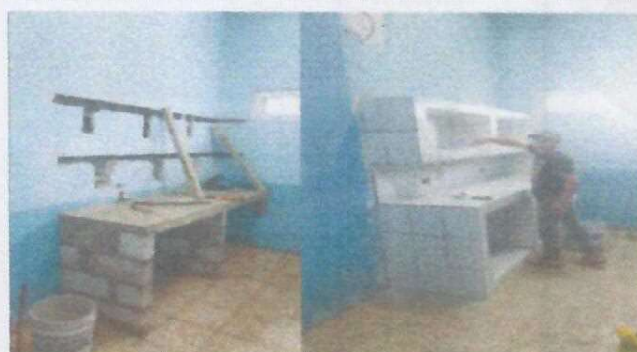
Foto 10: Instalando mesa de trabajo de concreto y azulejo.
