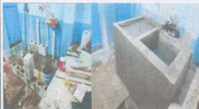
Foto 9: Instalando pila de mamposteria reforzada.
