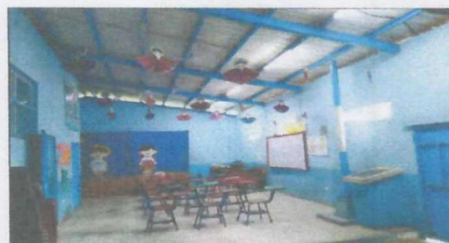
Foto 4: Sustitución de iluminación ( incluye foco led 50 Watts, plafonera, cableado)
