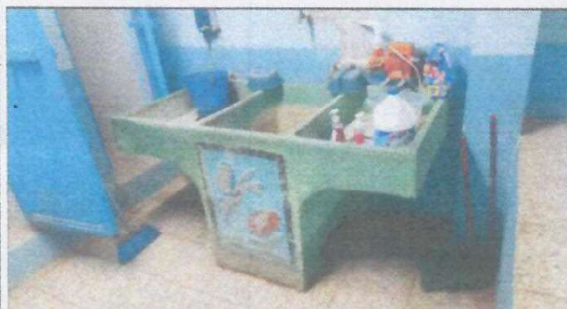
Foto 9: Instalación de pila mampostería reforzada (1.60 X 1, incluye drenaje)
