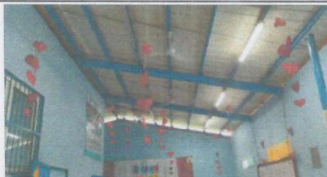
Foto 2: Cielo falso corredor.
