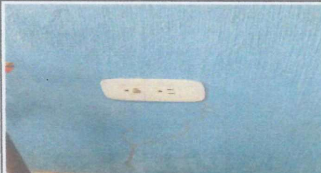
Foto1: Sustitución de tomacorrientes dobles. Incluye cable y otros accesorios.
