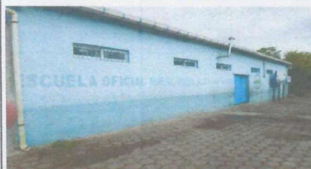
Foto 5: Instalación de lamparas solares en exterior.
