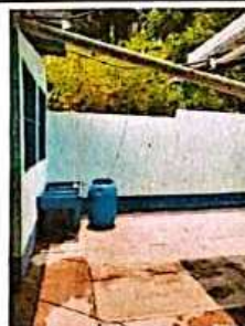
Foto 4: pila a reubicar y area donde se extendera el techo metalico.
