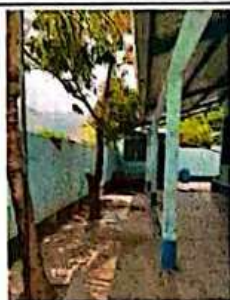
Foto 1: area exterior a colocar nivelacion y piso de granito.
