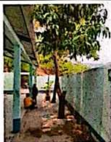
Foto 3: arboles a podar y extension de techo de estructura metalica.
