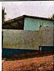
Foto 5: pintura exterior a aplicar en muros.
