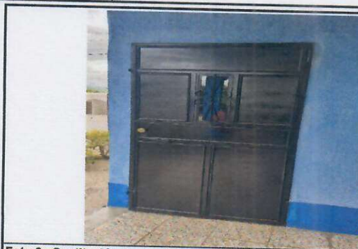
Foto 8: Sustitución de puerta
