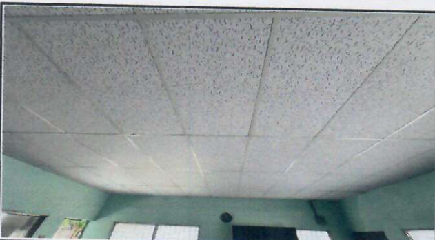
Foto 9: Instalación de cielo falso (incluye material y mano de obra) Dirección.
