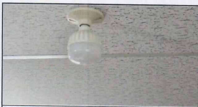
Foto 5: Sustrucción de plafoneras, incluye cable y accesorios.
