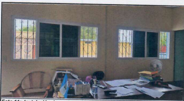
Foto 11: Instalación de ventanas de PVC corredizas con sedazo
