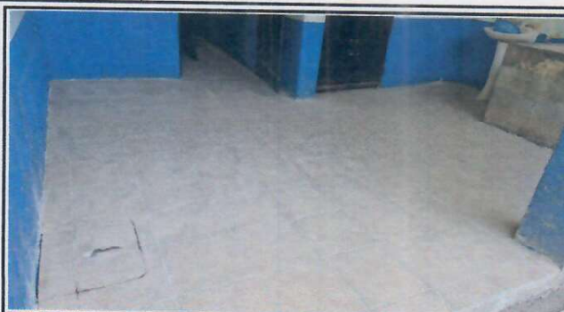
Foto 2: Sustrucción de piso, torta de concreto por piso antideslizante
