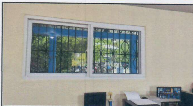
Foto 3: Instalaciones de ventanas de PVC, corrediza con sedazo.
