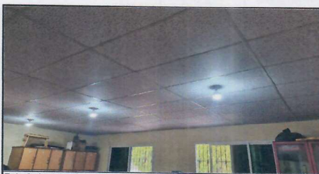
Foto 6: Instalación de cielo falso, (incluye materiales, mano de obra) sala de maestros.
