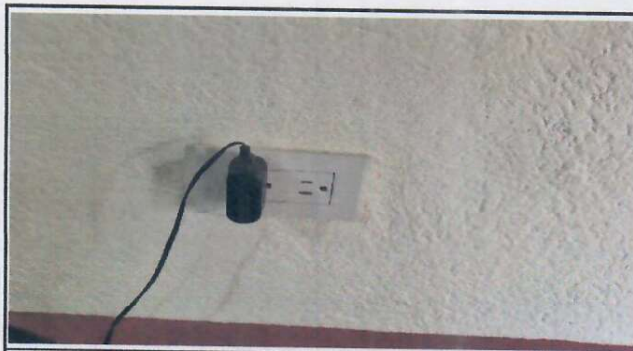
Foto 4: Sustrucción de tomacorrientes dobles, cable y accesorios.
