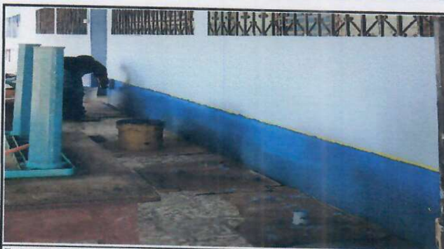
Foto 10: Pintura en muros interiores y exteriores
