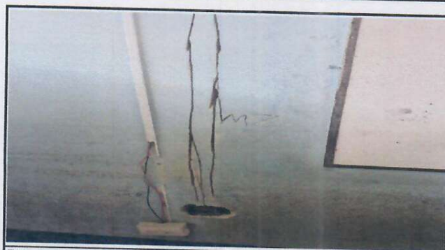
Foto 4: Sustitución de tomacorrientes dobles, cable y accesorios.
