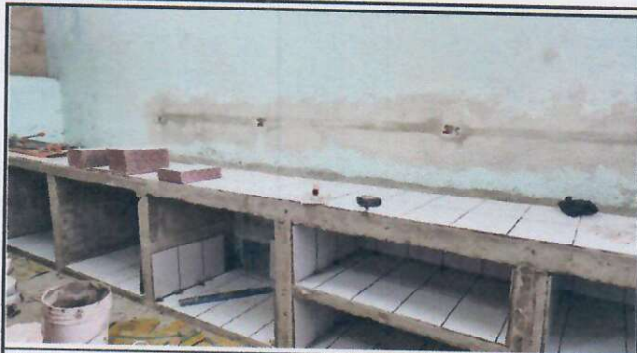
Foto 7: Instalación de mesa de concreto de 5.50 de largo, 1.00 de ancho, 0.90 de alto.
