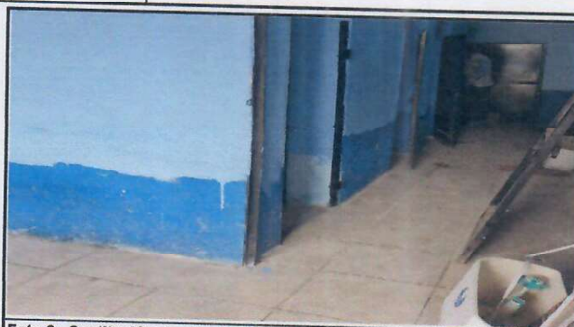
Foto 2: Sustitución de piso, torta de concreto por piso antideslizante
