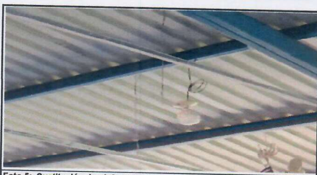
Foto 5: Sustitución de plafoneras, incluye cable y accesorios.
