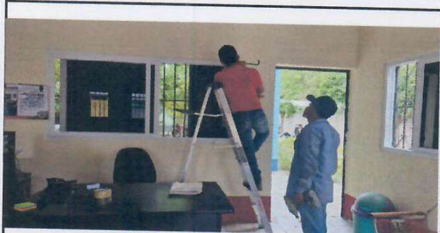
Foto 3: Instalaciones de ventanas de PVC, corrediza con sedazo.
