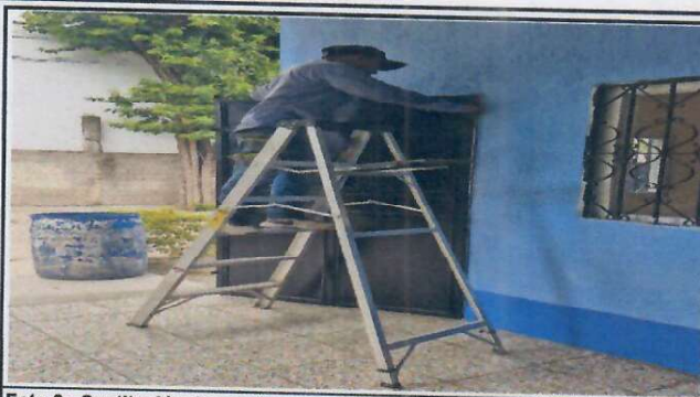
Foto 8: Sustitución de puerta
