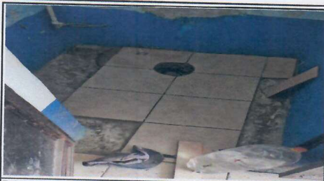
Foto 1: Sustitución de inodoro
