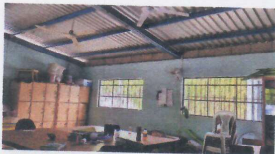
Foto 3: REPARACION DE SISTEMA ELECTRICO, CELO FALSO Y VENTANAS SALA DE MAESTROS
