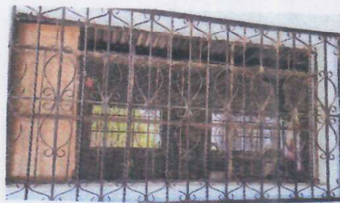
Foto 2: VENTANA A INSTALAR SALA DE MAESTROS
