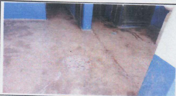
Foto 6: SUSTITUCIÓN DE PISO POR PISO ANTIDESLIZANTE EN SERVICIO SANITARIO
