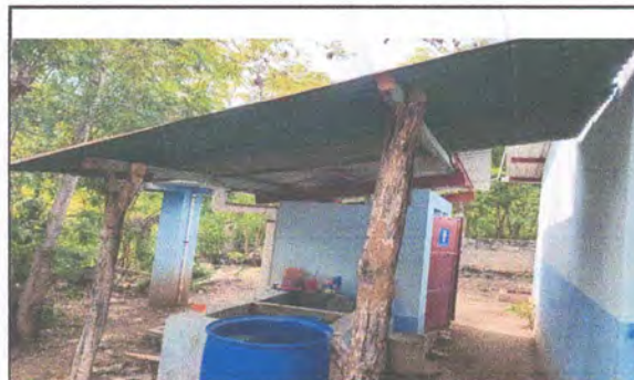
Foto 6: TRABAJOS EN BAÑOS, SUSTITUCIÓN DE LAMINA TROQUELADA, ESTRUCTURA DE SOPORTE Y AZULEJO EN PILA.
