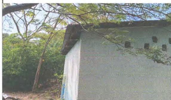
Foto 4: DEMOLICIÓN E INSTALACIÓN DE VENTANA DE METAL.
