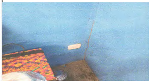
Foto 2: SUSTITUCIÓN DE TOMAFUERZA AULAS.
