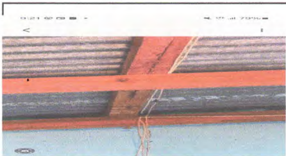
Foto 5: TRABAJOS EN SISTEMA ELECTRICO EN COCINA.
