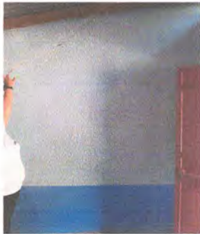
Foto 9: DEMOLER AREA PARA VENTANA
