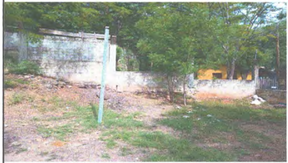
Foto 8: PINTURA EN MUROS.
