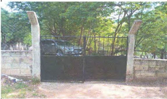
Foto 7: REMOZAMIENTO DE PORTON ENTRADA PRINCIPAL.
