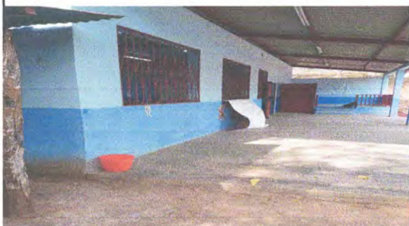
Foto1: PINTURA EN AULAS.
