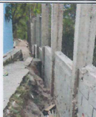
Foto 2: SUSTITUCION DE MURO PERIMETRAL .
