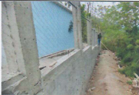
Foto 1: DEMOLICION DE MURO DE CONTENCIÓN Y EXTRACCIÓN DE RIPIO.
