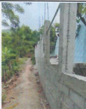
Foto 3: SUSTITUCION DE MURO PERIMETRAL .
