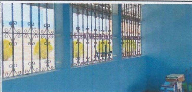
Foto 5: APLICACIÓN DE PINTURA EN MUROS.
