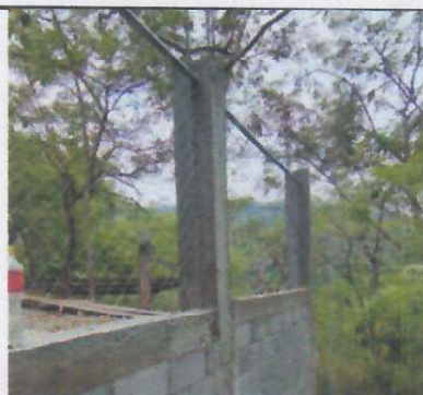
Foto 4: SUSTITUCION DE TUBO HG Y MALLA GALVANIZADA DE 1.5 MTS DE ALTO
