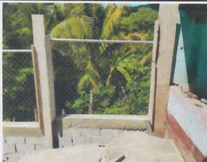
Foto 5: SUSTITUCION DE TUBO HG Y MALLA GALVANIZADA.
