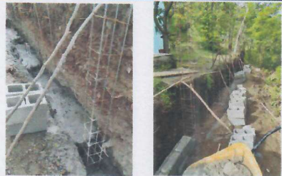
Foto 2: SUSTITUCION DE MURO PERIMETRAL .
