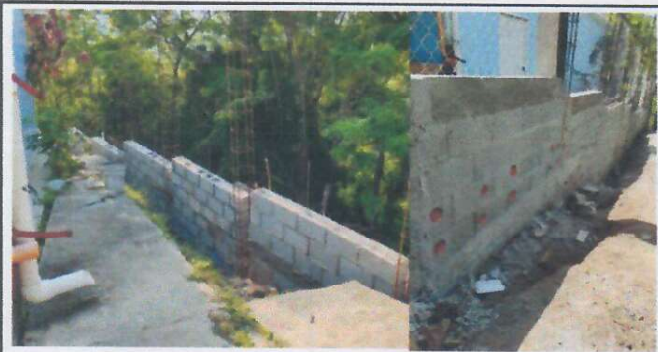
Foto 3: SUSTITUCION DE MURO PERIMETRAL .
