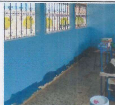
Foto 6: APLICACIÓN DE PINTURA EN MUROS.
