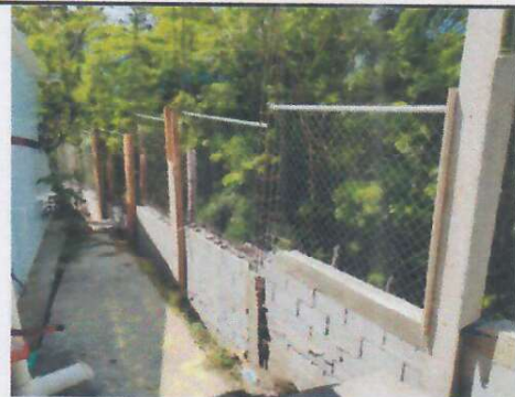
Foto 4: SUSTITUCION DE TUBO HG Y MALLA GALVANIZADA.
