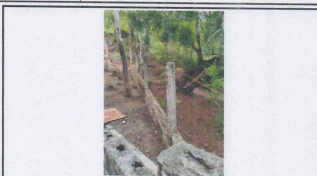
Foto 2: Cambio de Malla en muro perimetral.
