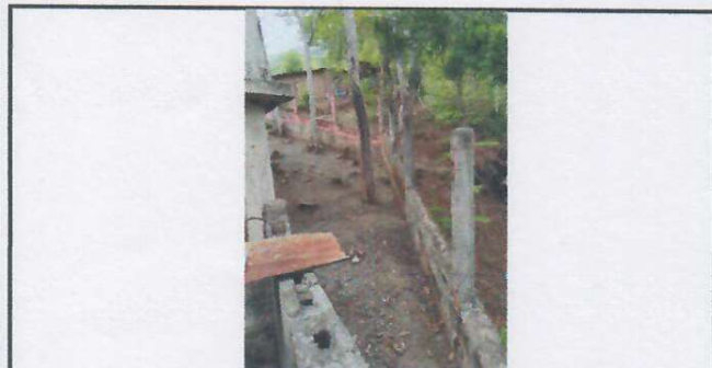
Foto 3: Cambio de malla en muro perimetral.
