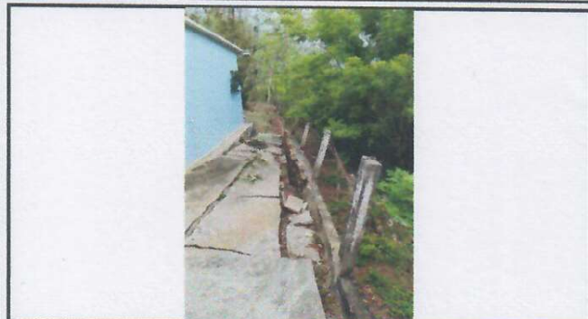
Foto 1: Reparacion de muro perimetral. Demolicion y Sustitucion.
