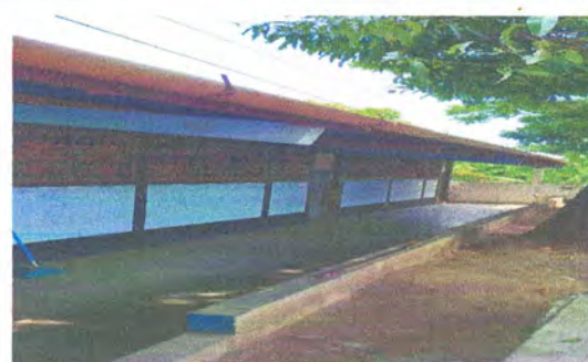
Foto 4: Instalación de canal.
