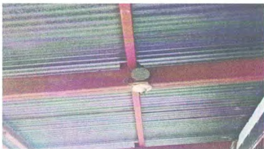
Foto 1: Sustrucción de iluminarias.
