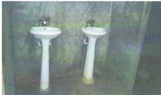
Foto 10: Sustrucción de accesorios de lavamanos.
