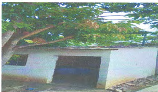
Foto 5: Sustrucción de lamina y estructura de soporte en cocina.
