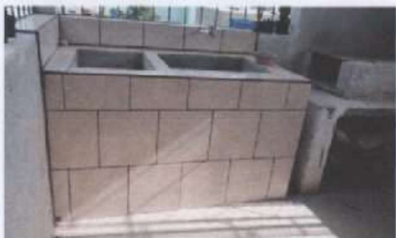
Foto 3: Instalación de Pila de Concreto en Cocina
