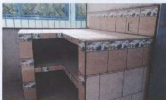
Foto 4: Instalación de mueble de concreto en Cocina
