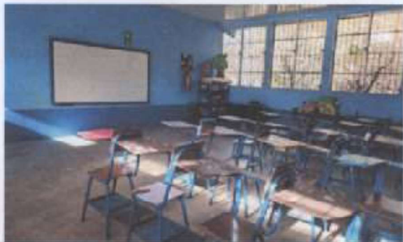
Foto 1: Pintura en muros interiores y exteriores
