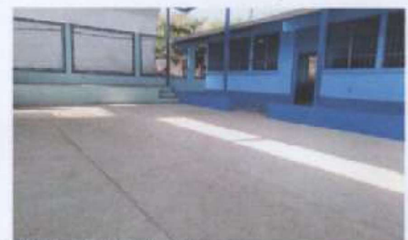
Foto 6: Sutilución de Planchas de Concreto
