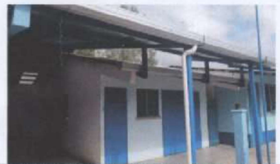
Foto 5: Instalación de Estructura de Soporte de metal, instalación de Lámina y sustitución de Canal PVC por Canal de metal
