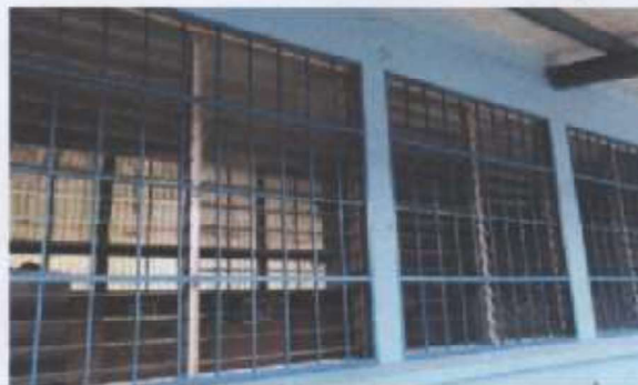
Foto 2: Mantenimiento de Balcones
