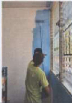
Foto 1: Pintura en muros interiores de Aula
