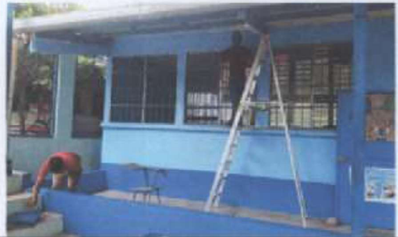
Foto 2: Pintura en muros exteriores de Aulas
