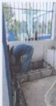
Foto 3: Instalación de Pila de Concreto en Cocina
