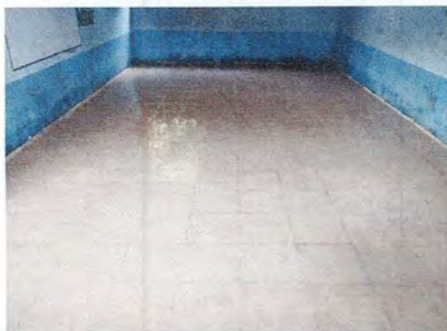
Foto 3: Piso cerámico ya instalado en aula.
