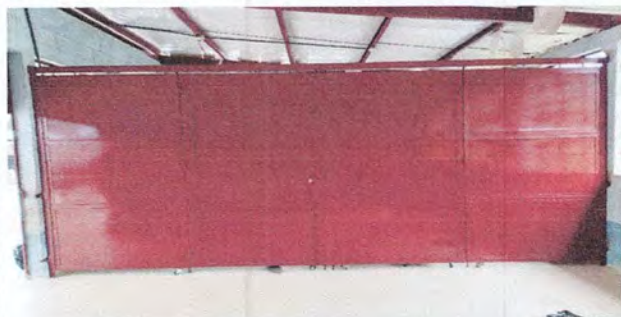
Foto 5: División de metal instalado en aula.
