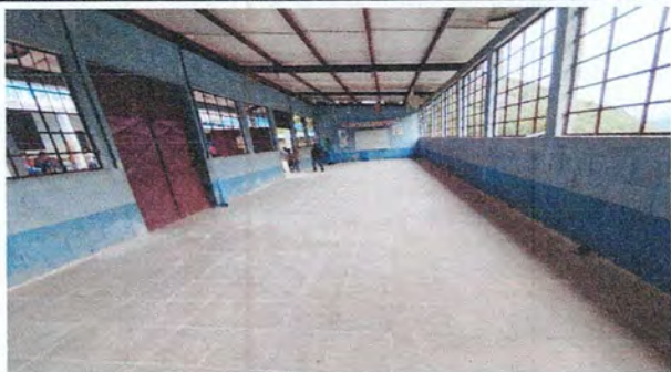
Foto1: Aula finalizada con la instalación de metros de piso cerámico.
