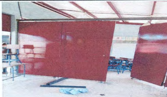
Foto 2: Colocación en aula la división de metal.
