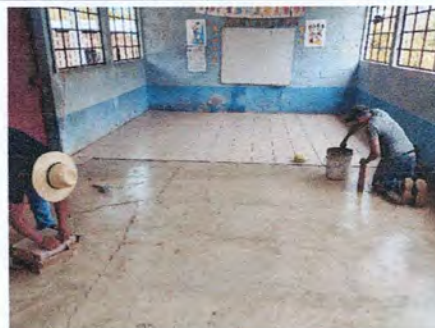
Foto 4: Instalación de piso cerámico en aulas.
