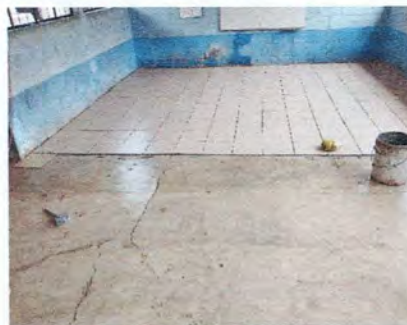
Foto 2: Colocación de piso cerámico.
