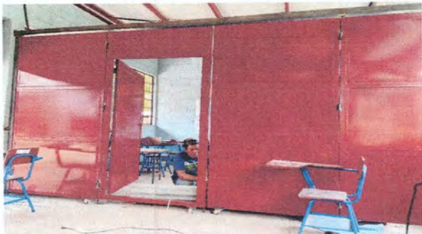
Foto1: Instalación de la división de metal en aula.
