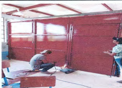
Foto 6: Mano de obra en las instalaciones de las divisiones de metal en aulas.
