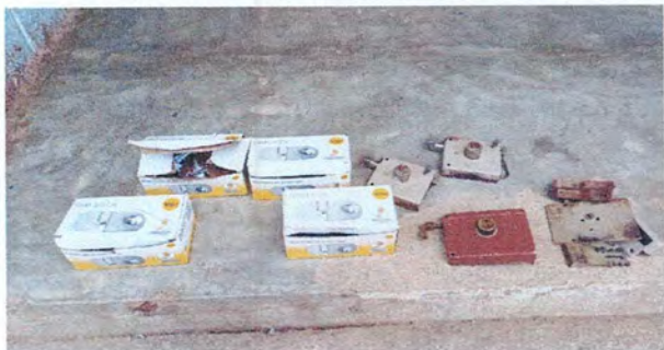
Foto 3: Sustitución de chapas marca yale en puertas de aulas.
