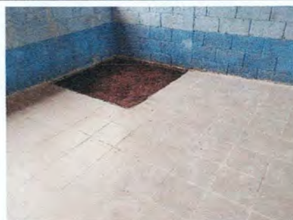
Foto 6: Reparación de hundimiento en aula, para continuar con la colocación del piso cerámico.
