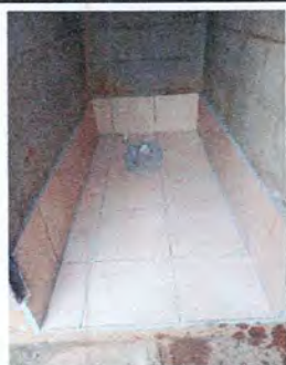
Foto 5: Preparación del espacio para la sustitución de un nuevo inodoro.
