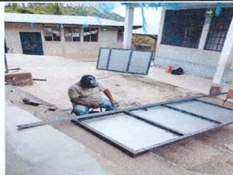
Foto 4: Fabricación de las divisiones de metal para aulas.
