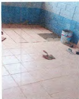
Foto 1: Mejoramiento de aulas con la instalación del piso cerámico.
