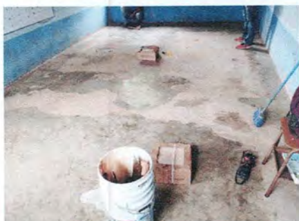
Foto 3: Preparación de los espacios en aulas para la instalación del piso cerámico.
