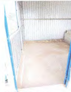
Foto 3: Instalación de piso en cocina
