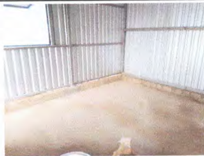
Foto 6: Instalación de piso en cocina
