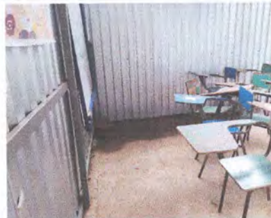
Foto 2: Instalación de piso de granito en aula
