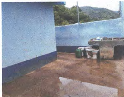
Foto 1: Sustrucción de pila de cemento
