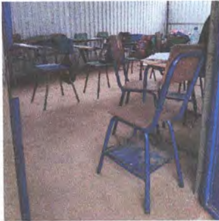
Foto1: Cambio de piso en aula
