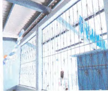
Foto 4: Instalación de ventanas de PVC
