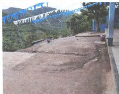
Foto 4: Sustrucción de concreto en patio
