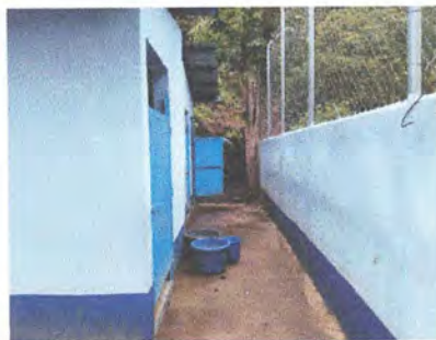
Foto 3: Instalación de bordillo de block para desviar aguas pluviales
