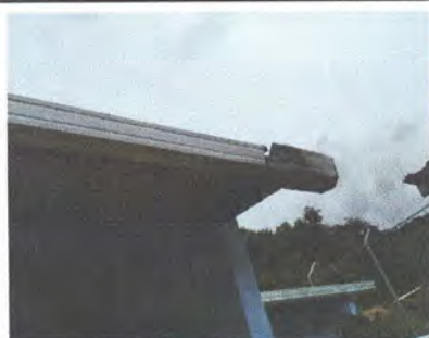
Foto 5: Mantenimiento de canal, retiro, reparación e instalación
