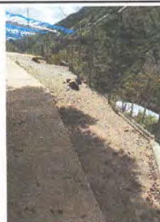
Foto 6: Reparación de muro de concreto.
