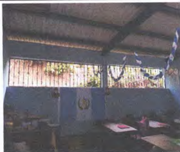
Foto 5: Instalación de ventanas de PVC
