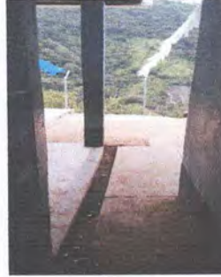
Foto 2: Instalación de regilla de metal
