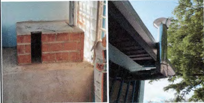
Foto 1 Instalación de estufa rural completa
