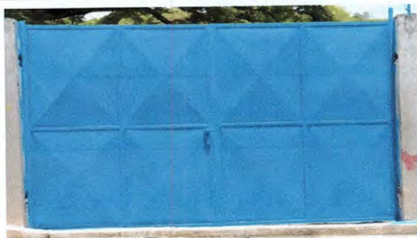
Foto 5 Instalación de Portón de metal
