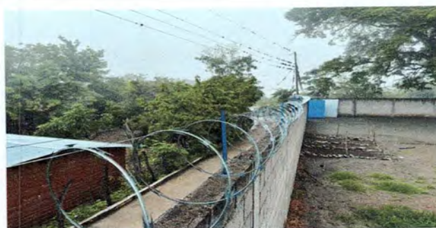
Foto 6 Protección de muro perimetral con Razor Ribbon
