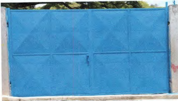
Foto 5 Instalación de Portón de metal
