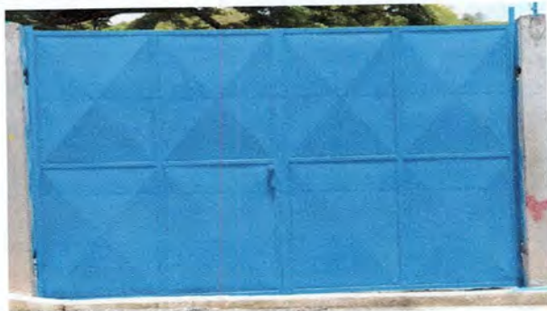
Foto 5 Instalación de Portón de metal
