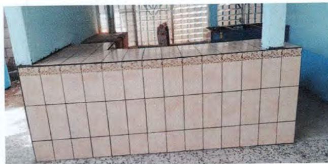
Foto 2. Mueble de concreto para cocina acabado de azulejo
