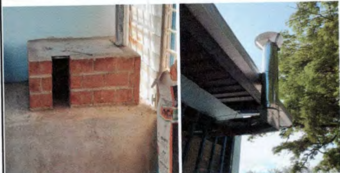
Foto 1 Instalación de estufa rural completa
