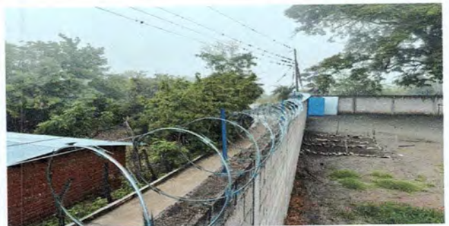
Foto 6 Protección de muro perimetral con Razor Ribbon
