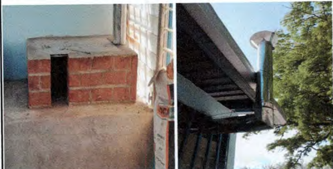
Foto 1 Instalación de estufa rural completa
