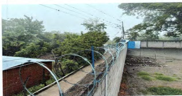
Foto 6 Protección de muro perimetral con Razor Ribbon
