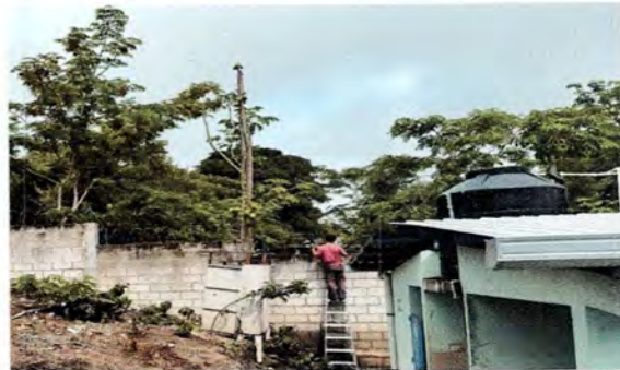
Foto 6. Instalación de Razor Ribbon
