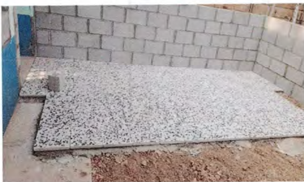
Foto 3. Instalación de piso de granito
