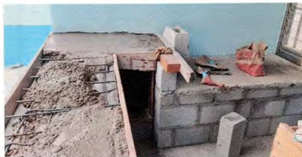
Foto 2. Construcción de mueble de concreto
