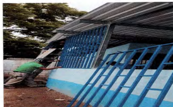
Foto 4. Instalación de balcones de metal
