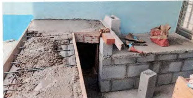
Foto 2. Construcción de mueble de concreto
