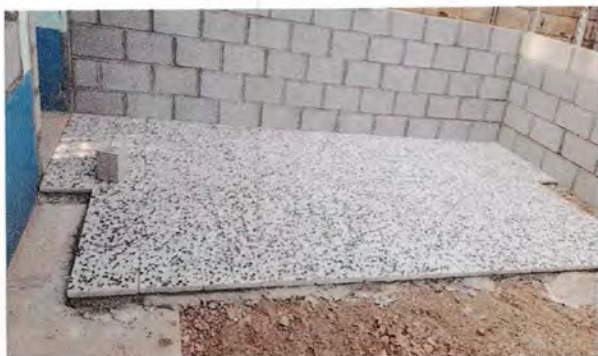
Foto 3. Instalación de piso de granito
