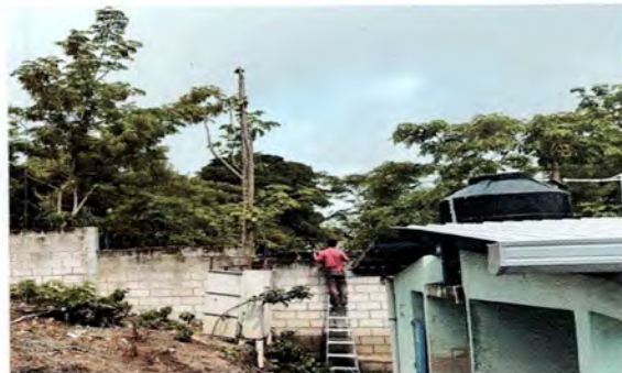
Foto 6. Instalación de Razor Ribbon
