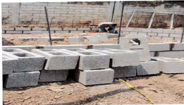
Foto 1. Ampliación de cocina
