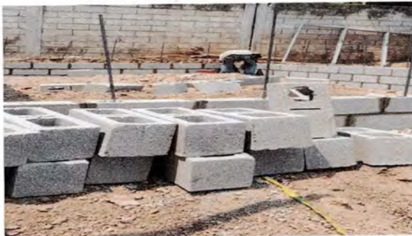
Foto 1. Ampliación de cocina
