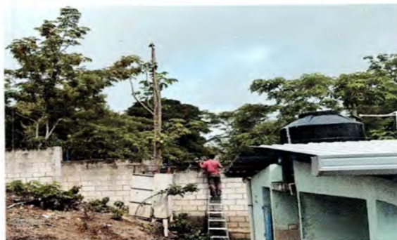
Foto 6. Instalación de Razor Ribbon
