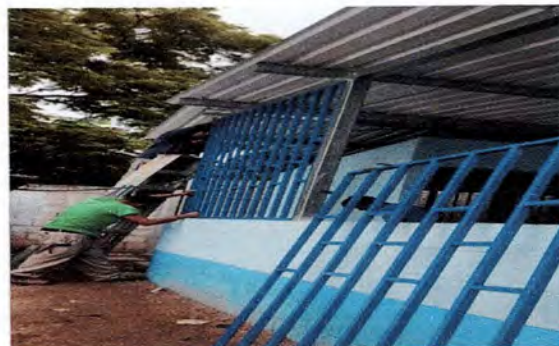
Foto 4. Instalación de balcones de metal
