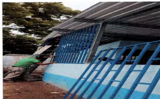
Foto 4. Instalación de balcones de metal
