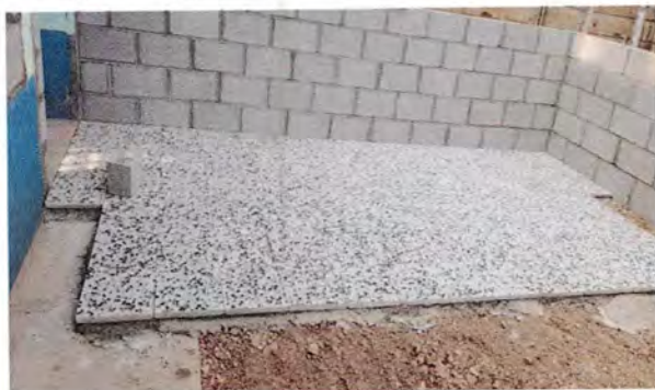
Foto 3. Instalación de piso de granito
