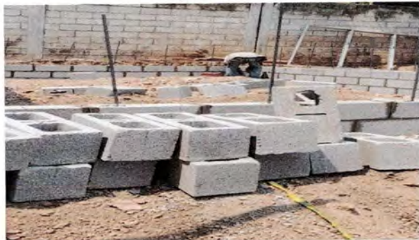
Foto 1. Ampliación de cocina
