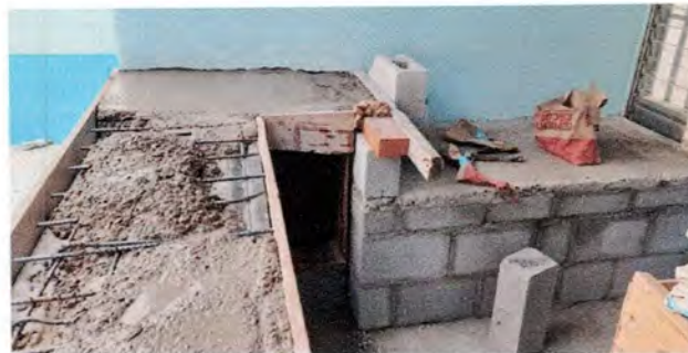
Foto 2. Construcción de mueble de concreto
