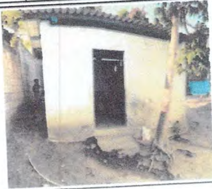
Foto 1: Reparación de Cocina.
