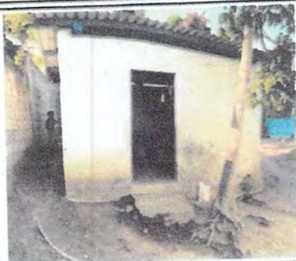
Foto 1: Reparación de Cocina.
