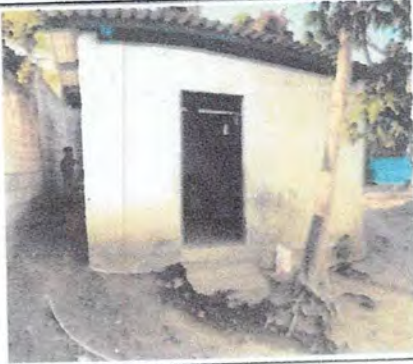
Foto 1: Reparación de Cocina.
