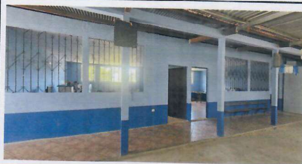
FOTO 4: PAREDES QUE NECESITAN REPELLO Y CERNIDO
