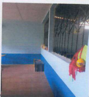
FOTO 5: PAREDES QUE NECESITAN REPELLO Y CERNIDO
