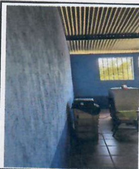
FOTO 5: PAREDES QUE NECESITAN REPELLO Y CERNIDO
