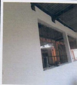
FOTO 4: PAREDES QUE NECESITAN REPELLO Y CERNIDO
