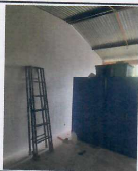
FOTO 5: PAREDES QUE NECESITAN REPELLO Y CERNIDO
