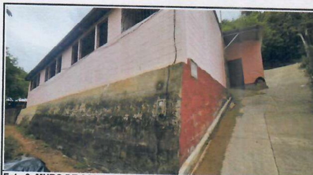
Foto 6: MURO DE CONTENCION DE AULAS QUE NECESITA SABIETA
