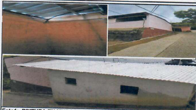
Foto 1: PINTURA EN MUROS EXTERIORES E INTERIORES EN MAL ESTADO
