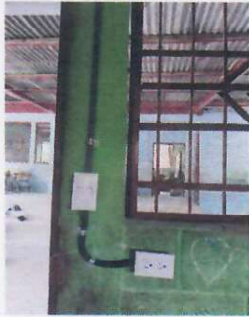
Foto 1: SUSTITUCIÓN DE LÁMINA SISTEMA ELECTRICO EN AULAS
