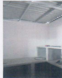
Foto 4: SUSTITUCIÓN DE LÁMINA Y ESTRUCTURA DE SOPORTE EN COCINA
