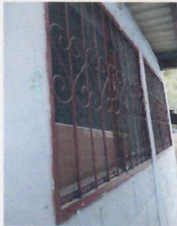
Foto 3: INSTALACIÓN DE MALLA MOSQUITERA EN BALCONES
