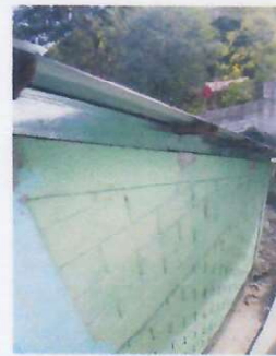
Foto 2: ENTABICAR MUROS ( SELLAR ESPACIOS ENTRE MURO Y TECHO)
