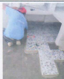
Foto 11: SUSTITUCIÓN DE PISO DE TORTA DE CONCRETO POR PISO DE GRANITO.
