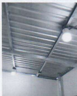
Foto 9: SUSTITUCIÓN DE SISTEMA ELECTRICO EN COCINA
