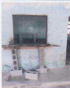
Foto 13: INSTALACIÓN DE DESAYUNADOR DE CONCRETO
