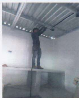
Foto 9: SUSTITUCIÓN DE SISTEMA ELECTRICO EN COCINA
