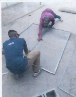
Foto 3: INSTALACIÓN DE MALLA MOSQUITERA EN BALCONES
