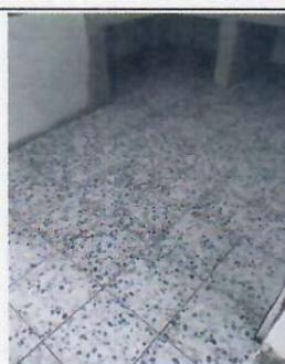
Foto 11: SUSTITUCIÓN DE PISO DE TORTA DE CONCRETO POR PISO DE GRANITO.
