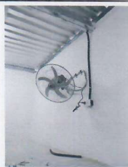
Foto 14: INSTALACIÓN DE VENTILADOR DE PARED
