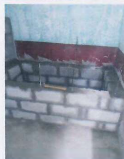
Foto 8: SUSTITUCIÓN DE PILA PLÁSTICA POR PILA DE CONCRETO ( 1.90 X 90 METROS)
