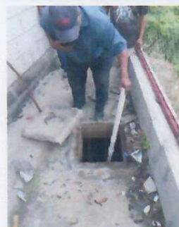
Foto 10: MANTENIMIENTO, VACIADO Y LIMPIEZA DE FOSA SÉPTICA. (VACIADO SERÁ A TRAVÉS DE SISTEMA)
