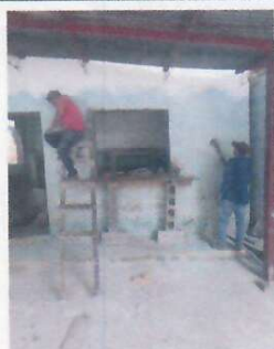
Foto 5: LEVANTADO, REPELLOS, CERNIDOS EN MUROS DE COCINA
