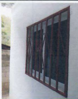
Foto 7: INSTALACIÓN DE VENTANA PVC Y BALCON
