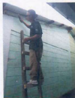
Foto 2: ENTABICAR MUROS (SELLAR ESPACIO ENTRE MURO Y TECHO DE LÁMINA)
