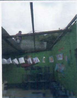
Foto 1: SUSTITUCIÓN DE LÁMINA, SISTEMA ELÉCTRICO EN AULAS
