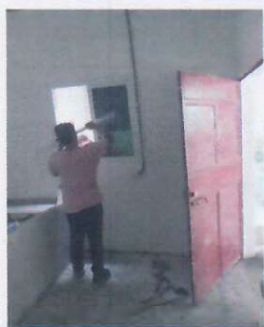
Foto 7: INSTALACIÓN DE VENTANA PVC Y BALCON
