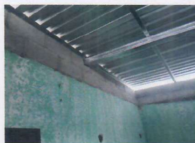
Foto 12: ENTABICAR MUROS EN COCINA
