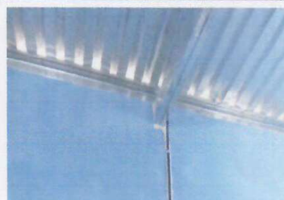
Foto 12: ENTABICAR MUROS EN COCINA
