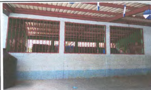
Foto 3: INSTALACIÓN DE MALLA MOSQUITERA EN BALCONES.
