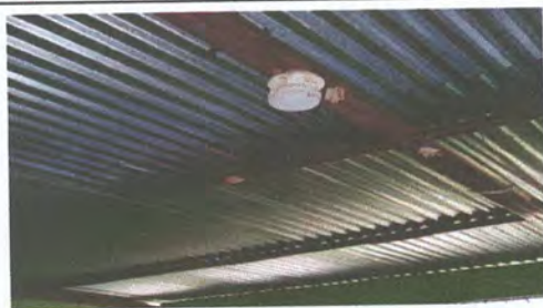
Foto 9: SUSTITUCIÓN DE SISTEMA ELECTRICO EN COCINA.
