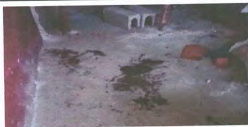
Foto 11: SUSTITUCIÓN DE PISO DE TORTA DE CONCRETO POR PISO DE GRANITO (PISO EXISTENTE CON MUCHAS GRIETAS)
