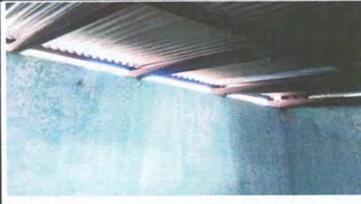
Foto 2: ENTAVICAR MUROS (SELLAR ESPACIO ENTRE MURO Y TECHO DE LÁMINA)
