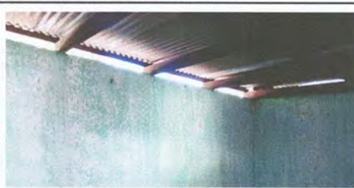
Foto 14: INSTALACIÓN DE VENTILADOR DE PARED
