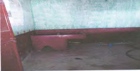
Foto 8: SUSTITUCIÓN DE PILA PLASTICA POR PILA DE CONCRETO. 1.90 metros de largo X 0.90 metros de ancho
