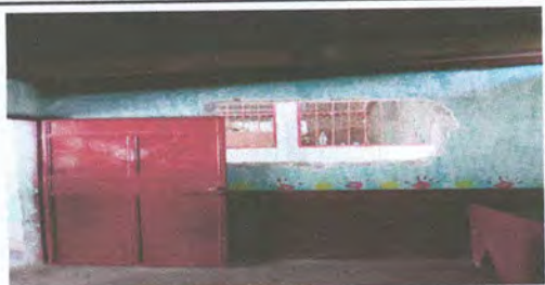
Foto 7: INSTALACIÓN DE VENTANA PVC Y VALCON.
