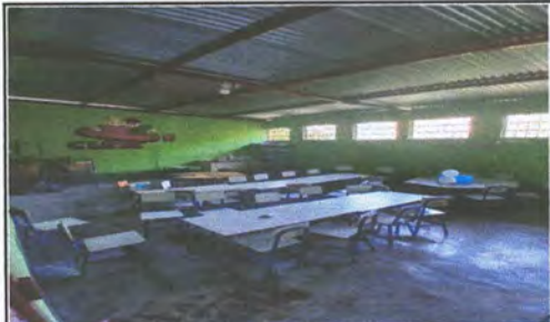
Foto 1: SUSTITUCIÓN DE LAMINA, SISTEMA ELECTRICO EN AULAS.
