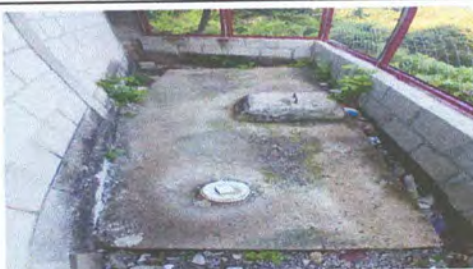
Foto 10: MANTENIMIENTO, VACIADO Y LIMPIEZA DE FOSA SEPTICA. (EL VACIADO SERÁ A TRAVÉS DE SISTEMA)
