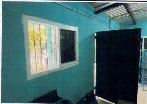
Foto 7: (COCINA) Se colocó ventanas de PVC para resguardar los alimentos en la cocina.
