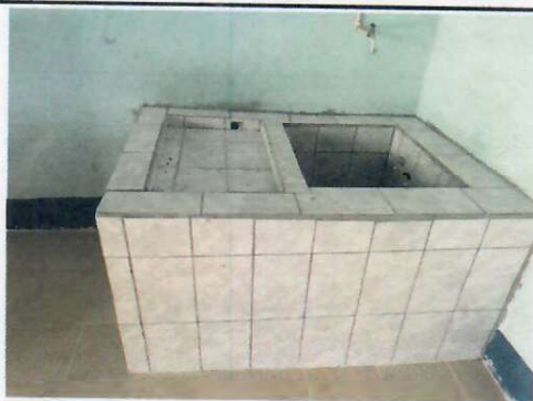
Foto 3: (COCINA) La pila de la cocina se instaló azulejos; con esta acción se controló la filtración de agua en las paredes de la pila.
