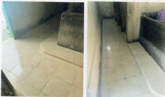
Foto 13: (BAÑOS) Se instaló piso cerámico en los baños de las niñas.
