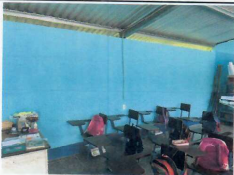
Foto 1: (AULAS) Se realizó el sellado de grietas en la pared de Tercer grado y Cocina; asimismo, la pintura de los espacios.
