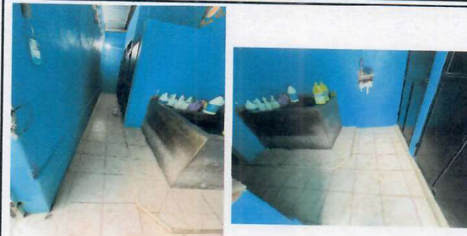
Foto 14: (BAÑOS) El módulo de servicios sanitarios de las niñas se aplicó pintura de aceite a las paredes.
