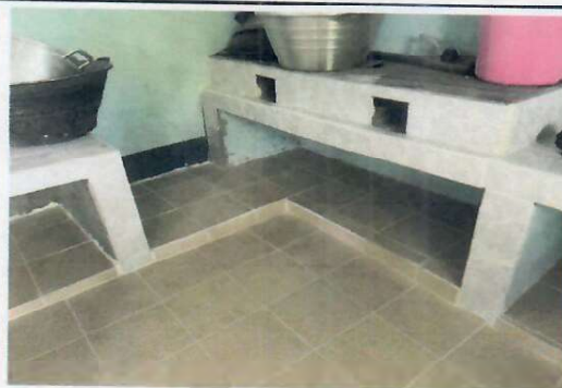
Foto 4: (COCINA) En el polletón se colocó azulejos. Se muestra una mejor presentación y de manera digna.
