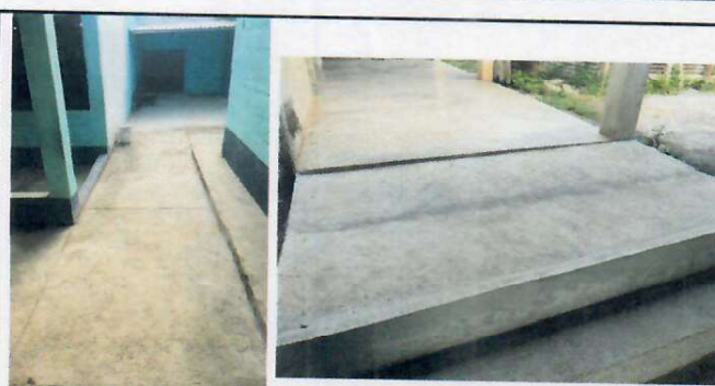
Foto 16: (PATIO) Se sustituyó las planchas de concreto, para ingreso a los baños y frente al depósito de agua.
