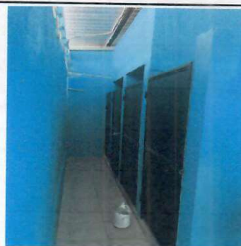
Foto 12: (BAÑO) Las puertas se controló la corrosión, y se aplicó la soldadura y pintura para el remozamiento completo.
