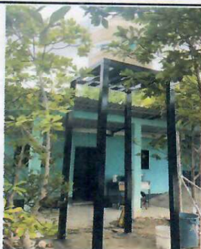
Foto 9: (COCINA) Se instaló la base de metal de tubo 4 x 4 galvanizado chapa 16 para el depósito de agua de 1100 litros de 2 metros de alto, y se posee un depósito de agua aéreo para abastecer la cocina.
