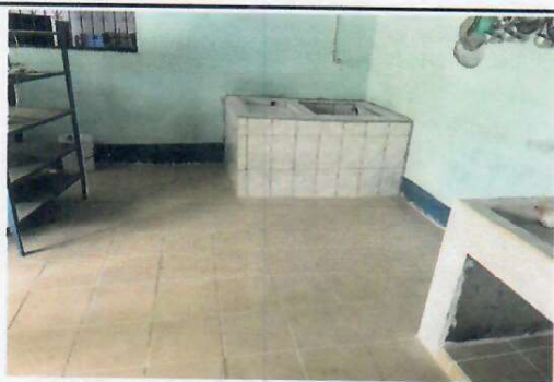
Foto 5: (COCINA) El piso de la cocina presenta piso cerámico.
