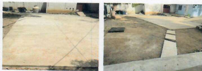
Foto 17: (PATIO) El ingreso al centro educativo, se sustituyó con tortas de concreto y así mejorar las condiciones peatonales.
