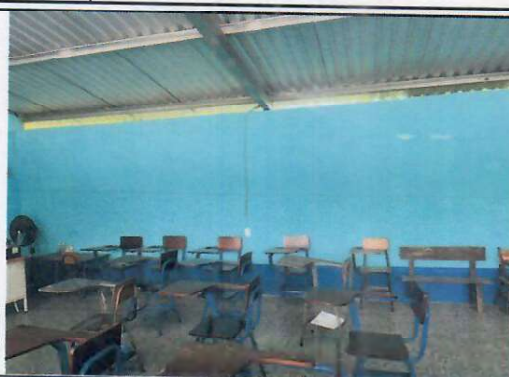
Foto 2: (AULAS) En el aula de primer grado se procedió tapar fisuras en la pared. También, se remozó la pared de los baños.
