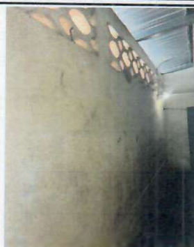
Foto 14: (BAÑOS) El módulo de servicios sanitarios se inicia con la limpieza de las paredes, para luego aplicar la pintura de aceite.
