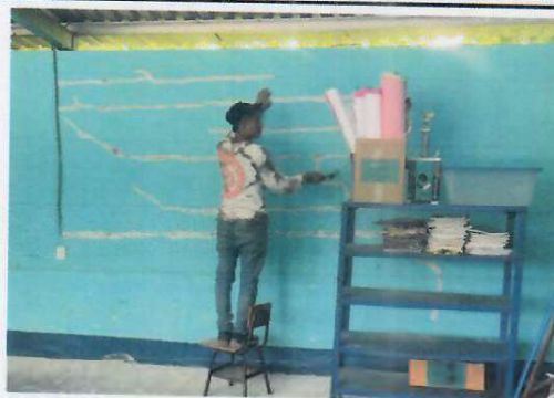
Foto 2: (Aulas) Las fisuras encontradas en las aulas de primero, tercer grado y cocina, están siendo trabajados por los albañiles.
