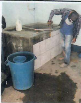
Foto 3: (COCINA) En la pila de la cocina se inició con la instalación de azulejos.
