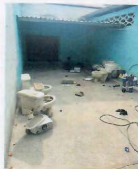
Foto 10: (BAÑOS) Se observa el proceso de sustitución de inodoros, en el modulo de servicios sanitarios de las niñas y niños respectivamente.
