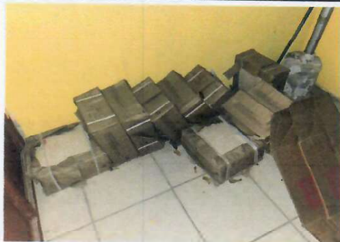
Foto 13: (BAÑOS) Se prosiguió con la compra de piso cerámico.
