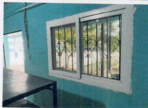
Foto 8: (COCINA) La cocina del plantel, en pleno remozamiento instalando ventanas de PVC.
