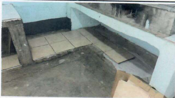
Foto 5: (COCINA) Se observa que en el piso de la cocina se le está colocando el cerámico.
