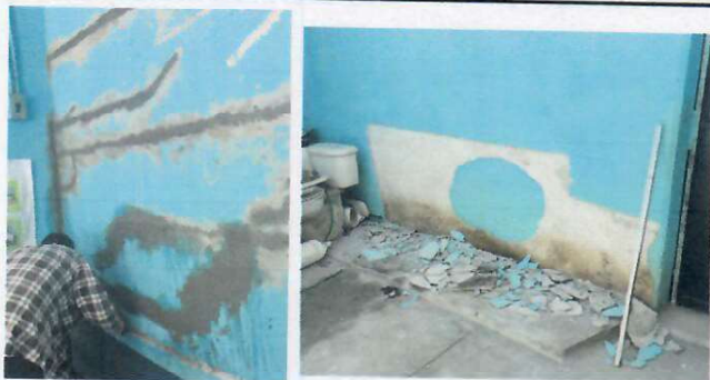
Foto 1: (Aulas) Se inició con el sellado de grietas en la pared.
