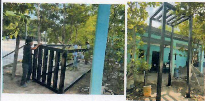
Foto 9: (COCINA) Se evidencia el proceso de instalación de una base de metal de tubo 4 x 4 galvanizado chapa 16 para el depósito de agua de 1100 litros de 2 metros de alto.
