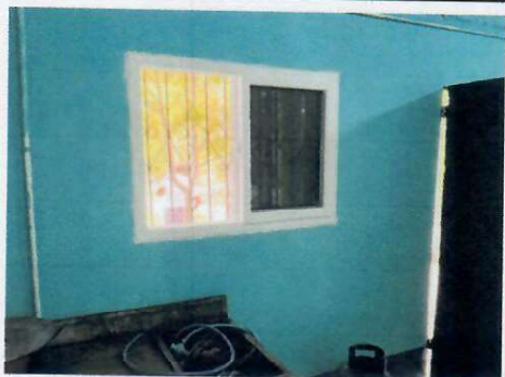
Foto 7: (COCINA) Las ventanas de PVC ya en proceso de colocación.
