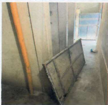
Foto 13: (BAÑOS) Instalación de piso cerámico en los baños
