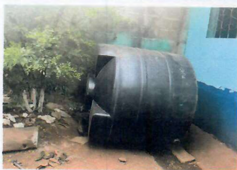
Foto 9: (COCINA) La instalación de una base de metal de tubo 4 x 4 galvanizado chapa 16 para el depósito de agua de 1100 litros de 2 metros de alto, es importante porque el agua es escasa en el centro educativo.
