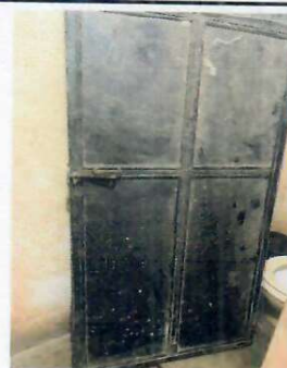
Foto 12: (BAÑO) Las puertas necesitan mantenimiento para controlar la corrosión, y la soldadura y pintura son algunas alternativas.
