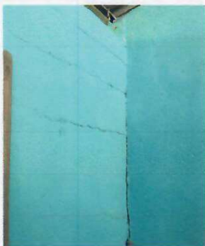
Foto 1: (AULAS) Se realizará el sellado de grietas en la pared.
