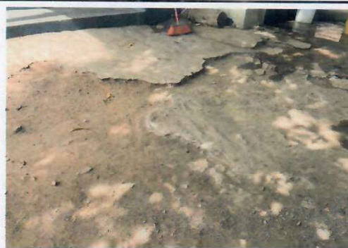
Foto 16: (PATIO) Sustitución de planchas de concreto, ingreso de baños y frente al depósito de agua.
