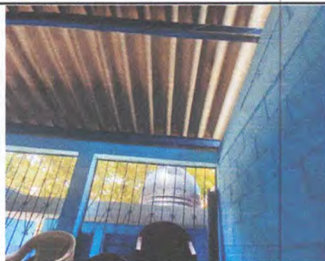
Foto 2: Reparación de Cubierta de Techo de AULA. Debe Removerse la Lámina Perfil 10 o de Asbesto cemento para darle Mantenimiento a la Estructura Existente y Luego Sustituir Lámina Troquelada C26 Legítima.
