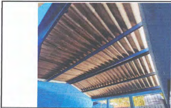
Foto 3: Reparación de Cubierta de Techo de AULA. Debe Removerse la Lámina Perfil 10 o de Asbesto cemento para darle Mantenimiento a la Estructura Existente y Luego Sustituir Lámina Troquelada C26 Legítima.
