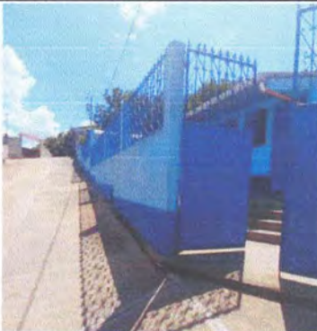
Foto 7: Sustruir Estructura Existente y Luego Sustruir Lámina Troquelada C26 Legítima en PATIO Y ACCESO PRINCIPAL. Y Aplicación Pintura Latex Parte Externa Muro Perimetral.
