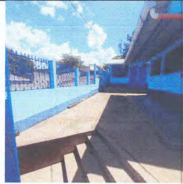
Foto 8: Sustruir Estructura Existente y Luego Sustruir Lámina Troquelada C26 Legítima en PATIO Y ACCESO PRINCIPAL.
