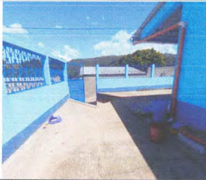
Foto 9: Sustruir Estructura Existente y Luego Sustruir Lámina Troquelada C26 Legítima en PATIO Y ACCESO PRINCIPAL.
