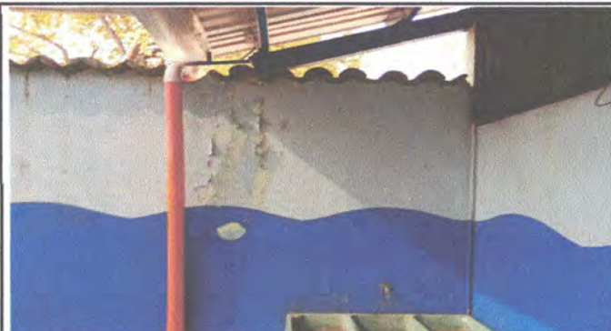
Foto 2: PINTURA EN MUROS EXTERIORES E INTERIORES
