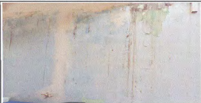
Foto 1: PINTURA EN MUROS EXTERIORES E INTERIORES
