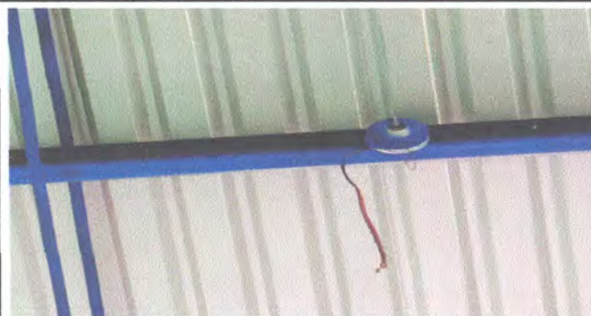
Foto 4: SUSTITUCION DE PLAFONERAS (INCLUYE CABLES)
