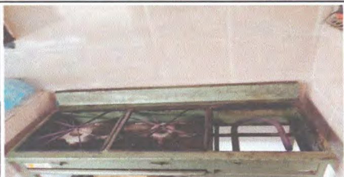
Foto 7: SUSTITUCION DE ESTUFA RURAL (COMPLETA) INCLUYE CHIMENEA Y PLANCHA DE METAL
