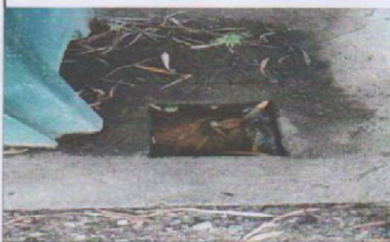
Foto 4: Sustitución de tubería de aguas negras.
