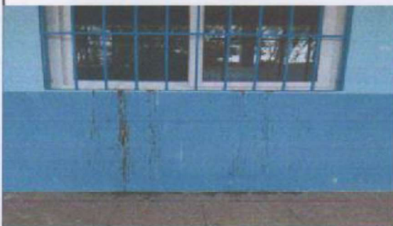
Foto 1: Pintura en aulas.
