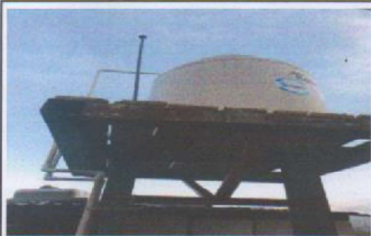
Foto 5: Sustitución de depósito de agua y base de metal.
