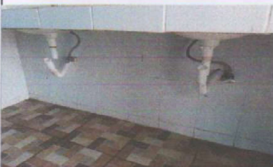
Foto 3: Sustitución de accesorios de lavamanos y baños.
