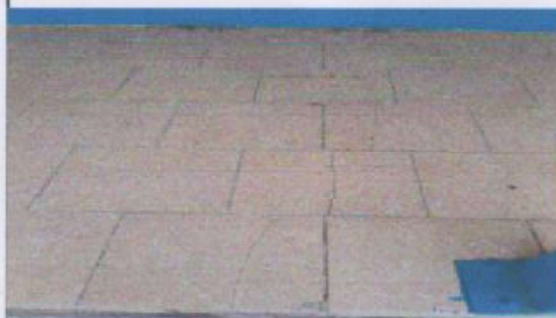
Foto 2: Sustitución de piso cerámico.
