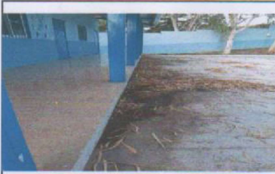
Foto 6: Cuneta de concreto y rejillas a instalar.
