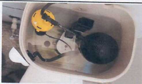
Foto 5: SUSTITUCIÓN DE ACCESORIOS INODORO
