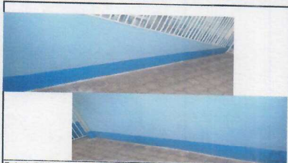
Foto 4: REPELLO EN MURO
