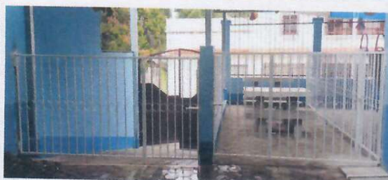
Foto 6: SUSTITUCIÓN DE BARANDAS DE METAL
