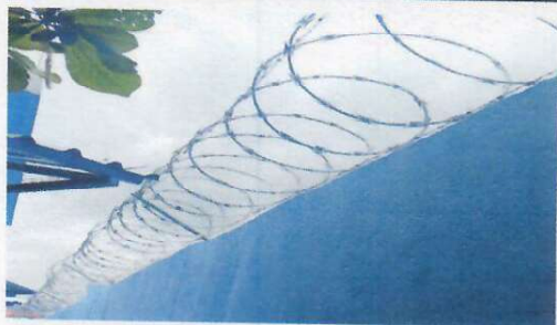
Foto1: INSTALACIÓN DE ALAMBRE DE RAZOR EN MURO PERIMETRAL
