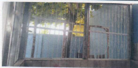
Foto 3: INSTALACIÓN DE BALCONES EN VENTANAS DE COCINA ESTO INCLUYE LA INSTALACIÓN DE CEDAZO PARA EVITAR EL INGRESO DE INSECTOS
