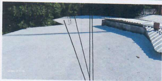
Foto 1: LOSA A IMPERMEABILIZAR
