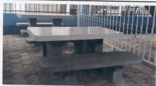
Foto 5: INSTALACIÓN DE MESAS CON SUS RESPECTIVAS BANCAS DE CONCRETO MESAS DE 1.50*0.80 *0.75 METROS Y BANCAS DE 1.50*0.55*0.42 METROS
