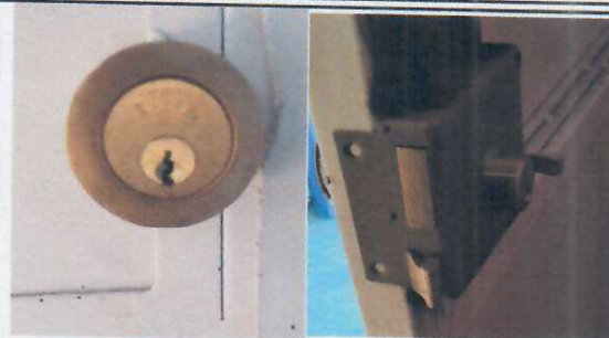
Foto 2: CAMBIO DE CHAPAS EN PUERTAS
