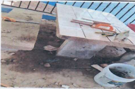
Foto 5: INSTALACIÓN DE MESAS CON SUS RESPECTIVAS BNCAS LAS CUALES SERA DE CONCRETO. MESAS DE 1.50 * 0.80 * 0.75 METROS Y BANCAS DE 1.50 * 0.55 * 0.42 METROS
