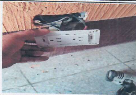
Foto 2: SUSTITUCIÓN DE TOMACORRIENTES
