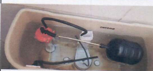
Foto 5: SUSTITUCIÓN DE ACCESORIOS INODORO
