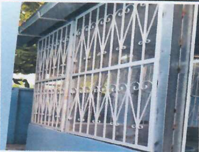
Foto 3: INSTALACIÓN DE BALCONES EN VENTANAS DE COCINA, ESTO INCLUYE LA INSTALACIÓN DE CEDAZO PARA EVITAR EL INGRESO DE INSECTOS
