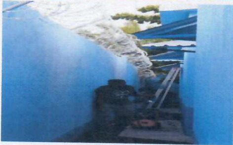
Foto 1: INSTALACIÓN DE ALAMBRE DE RAZOR EN MURO PERIMETRAL
