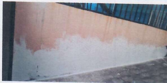
Foto 4: REPELLO EN MURO
