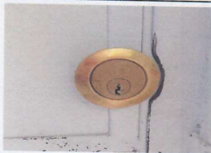
Foto 2: CAMBIO DE CHAPAS EN PUERTAS
