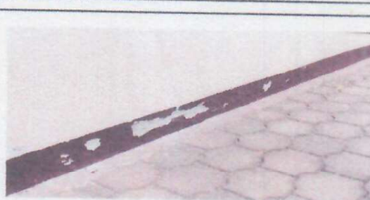
Foto 4: REPELLO EN MURO
