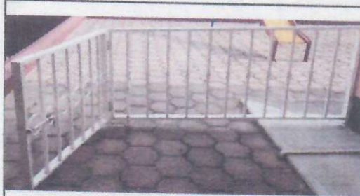
Foto 6: SUSTITUCIÓN BARANDA DE METAL
