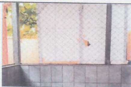
Foto 3: INSTALACIÓN DE BALCONES EN VENTANAS DE COCINA, ESTO INCLUYE LA INSTALACION DE CEDAZO PARA EVITAR EL INGRESO DE INSECTOS.
