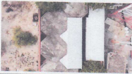
Foto 1: LOSA A IMPERMEABILIZAR
