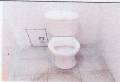
Foto 5: SUSTITUCIÓN DE ACCESORIOS INODORO
